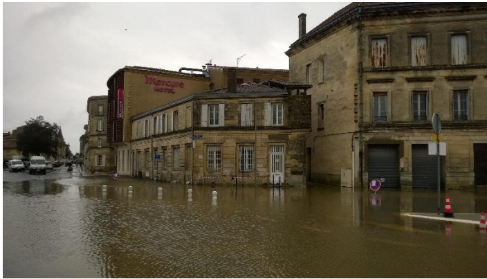
Inondations à Libourne février 2016
