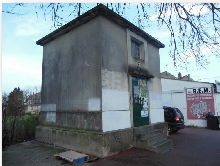
Figure 38 : Transformateur « hors sol »
