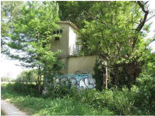
Figure 63 : Station de pompage désaffectée sur la commune de Pinsaguel
