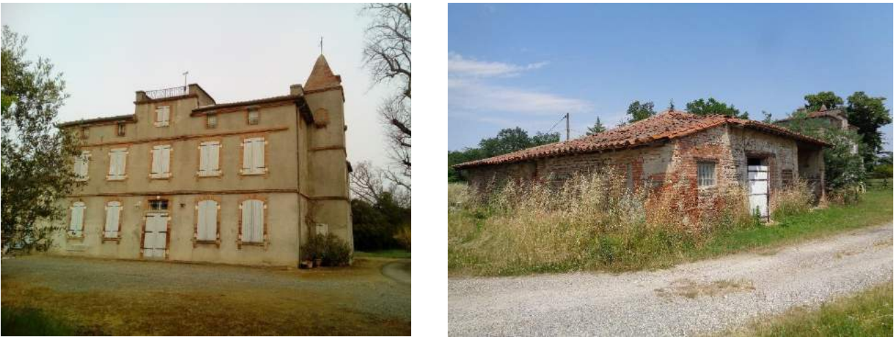
Figure 37 : Maison de maître (bâtiment A) (à gauche) et une des diverses bâtisses visitées (bâtiment D) (à droite)
