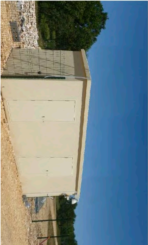
Local Poste de Livraison: béton peint ivoire RAL 9010 menuiseries ivoire RAL 9010 toiture béton pente 2%
