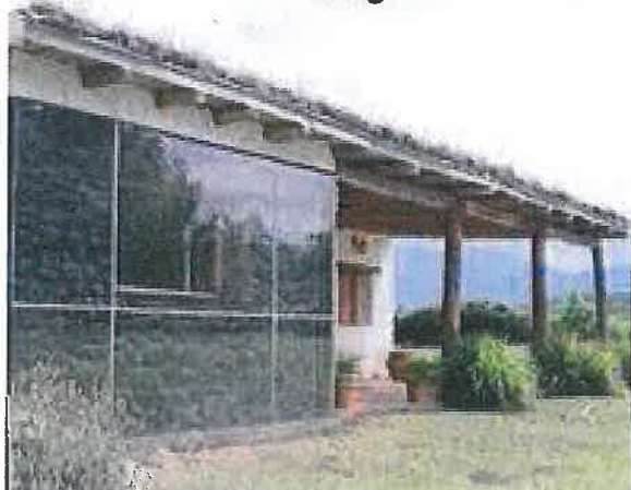
Le mur trombe : un moyen de capter l'énergie solaire à des fins de chauffage
