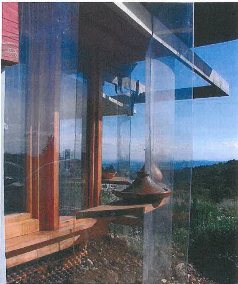
Double vitrage doublé d'une « peau » en plaques de polycarbonate à 30 cm de la façade : équivalence thermique d'un mur isolé par 40 cm de ouate de cellulose (Cantercel)
