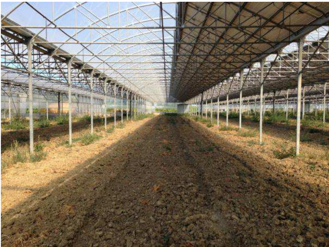
Serre multichapelle – préparation du terrain
