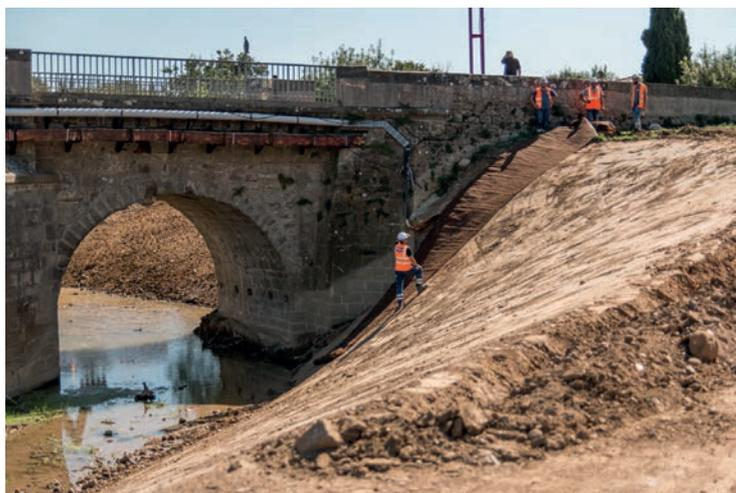
Travaux permettant la ré-ouverture de l'ensemble des arches du pont canal - © Ville de Trèbes
