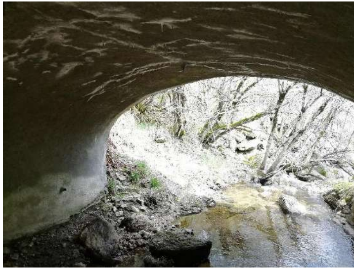
Figure 18 : Pont d'«aucun intérêt » pour les chiroptères, L. VINCENTI © EODD, 2020
