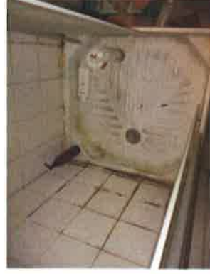
Traces d'humidité sur le mur de la salle d'eau
