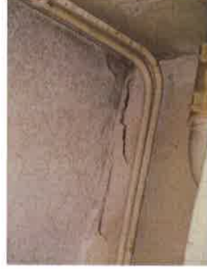
Mur de la cuisine coté intérieur
