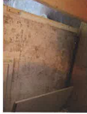
Traces d'humidité sur le mur de la cuisine (donnant sur la cour)
