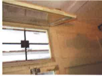
Absence de joint sur la partie ouvrante du vitrage de la porte cuisine
