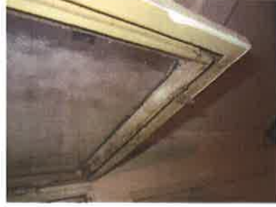
Absence de joint sur la partie ouvrante du vitrage de la porte cuisine
