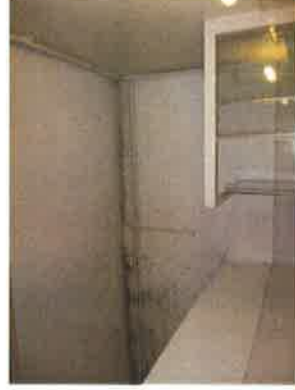
Traces d'humidité sur le mur de la salle d'eau
