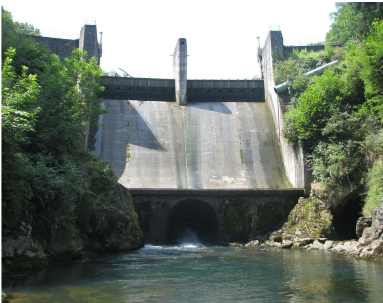
FIGURE 3 - BARRAGE DE CASTILLON DEPUIS L'AVAL
