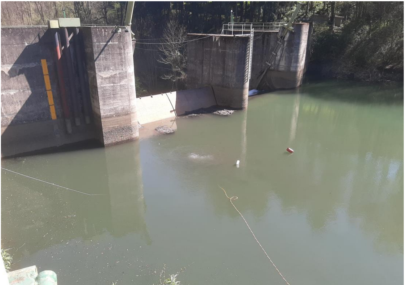
FIGURE 6 - INTERVENTION DE L'EQUIPE DE SCAPHANDRIERS (LES BOUEES FLOTTANTES REPRESENTANT LE MASSIF BETON DE LA VANNE CALZONI)
