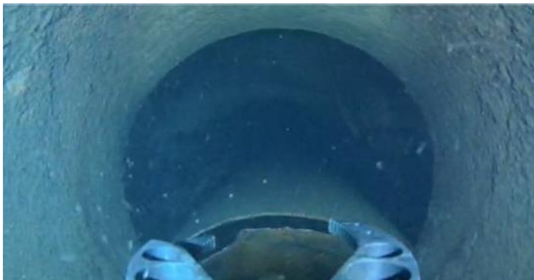
FIGURE 4 - PHOTO ISSUE DE L'INSPECTION DE LA CONDUITE FORCEE AU ROV
