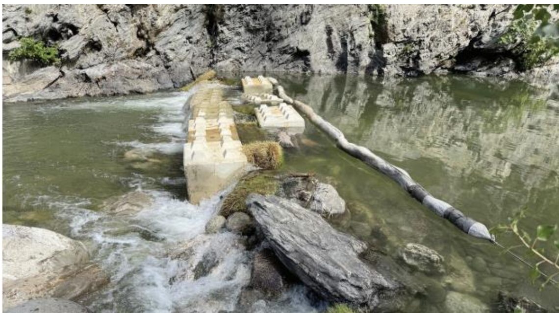
FIGURE 12 - EXEMPLE DE BARRIERE FILTRANTE CONSTRUITE DANS LE CADRE DE TRAVAUX EN RIVIERE AUTRES
