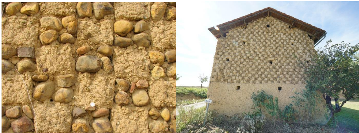
Murs en damiers constitués de terre crue et de galets
