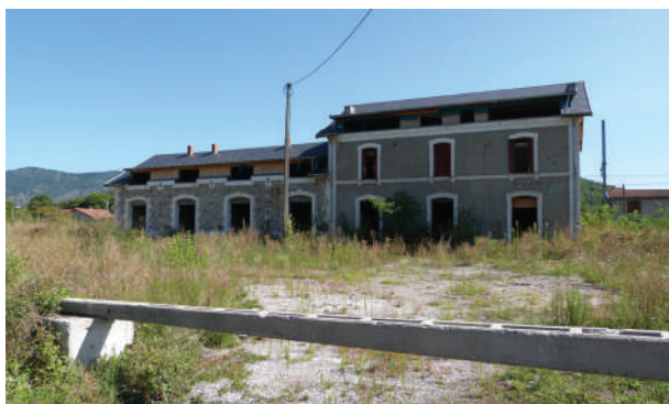
31. Saint-Paul-de-Jarrat / bâtiment désaffecté
