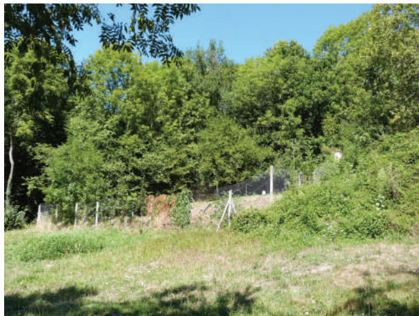
25. Cazenave-Allens / station d'épuration
