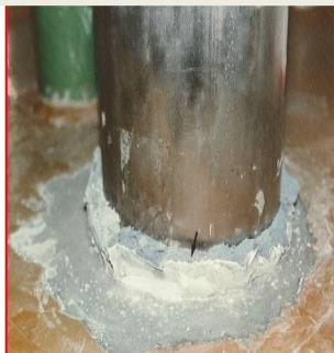
Enduits de rebouchage
