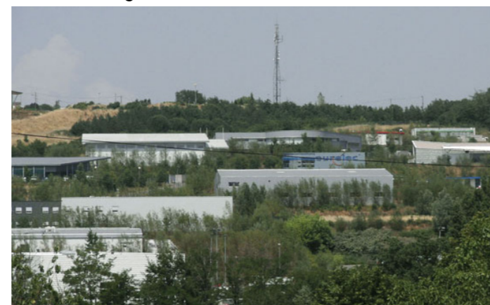
traitement soigné de la co-visibilité
