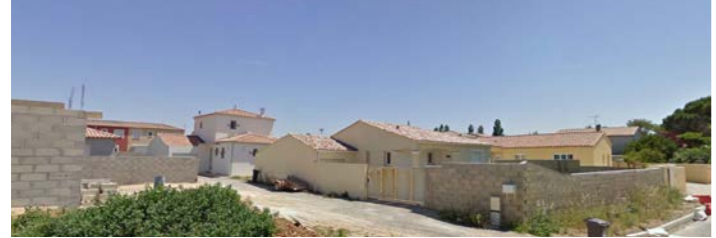
Quartier pavillonnaire résidentiel: la villa individuelle
