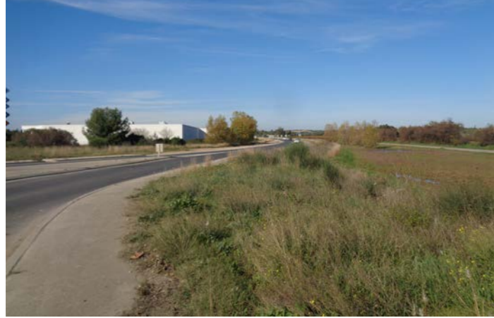
Environnement proche au Sud-Est du site - vue depuis le rond point de la RD34 / bassin de rétention
