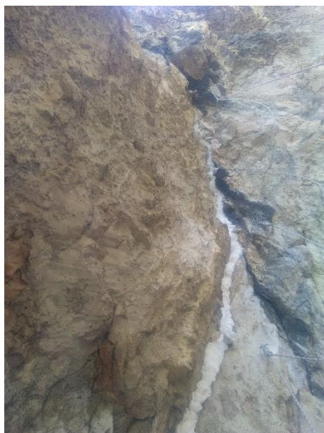
Utilisation de géotextile pour obstruer les fissures non occupées. A gauche, fissure étroite. A droite, fissure large.
