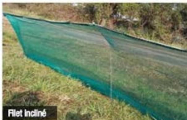
**Filet anti-intrusion incliné, en complément de la barrière de chantier**
