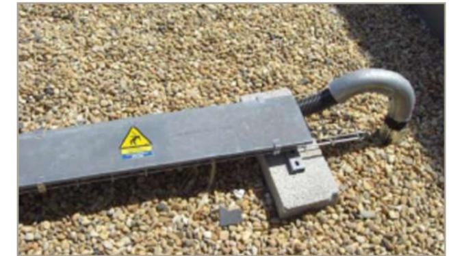
Figure n°7 : Chemin de câble en surface
