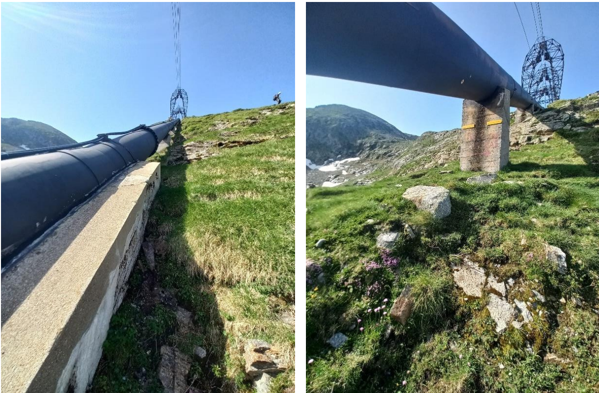
Figure 3. Massif semi-englobant (à gauche) et sellettes de soutien (à droite)
