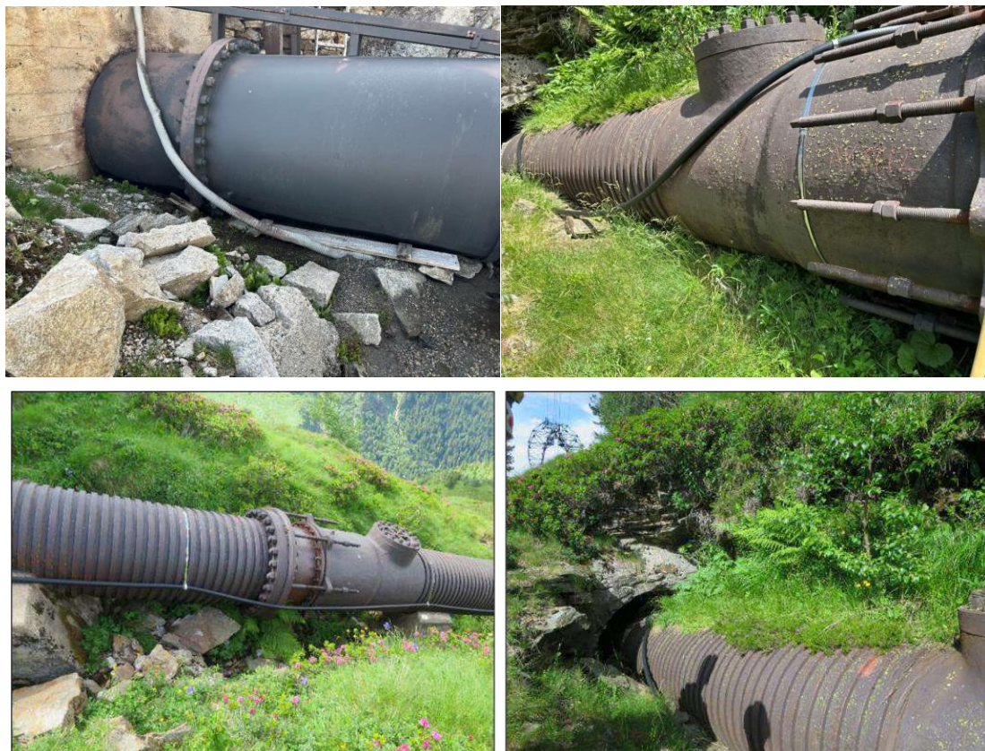
Figure 24 : Exemple de zones devant faire l'objet du rétablissement du tirant d'air sous la conduite
