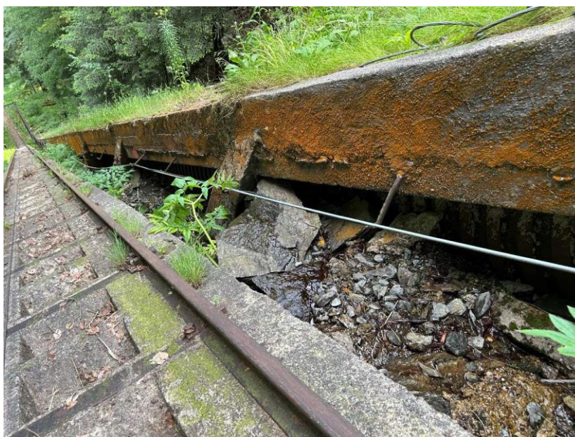
Figure 18 : Exemple d'une zone à déblayer à l'aval de la galerie, sous le platelage de protection de la CF (source GETEC)
