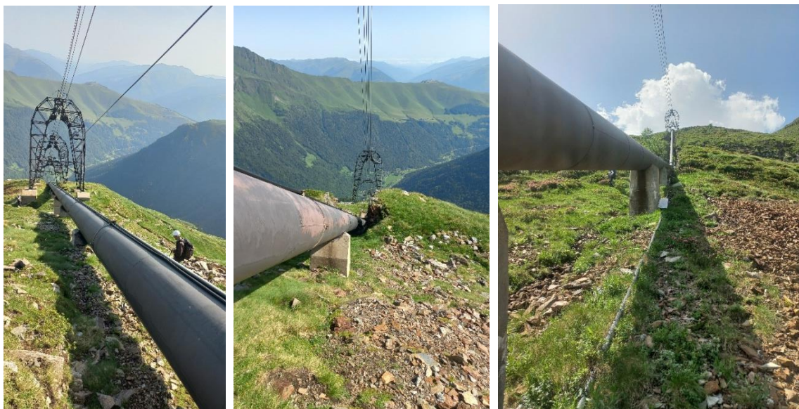
Figure 33. Illustrations des milieux au droit de la conduite dans sa partie supérieure (zone de travaux N°3) (Source : ING'EUROP juin 2025)
