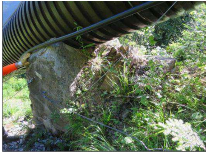
Figure 25 : Exemple d'une sellette à réfectionner
