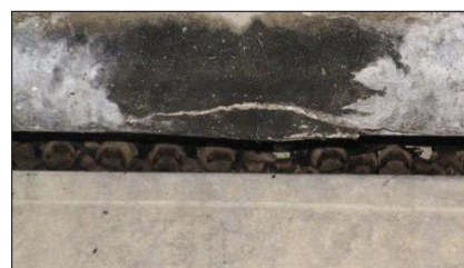
Colonie de Pipistrelle pygmée sous un pont
