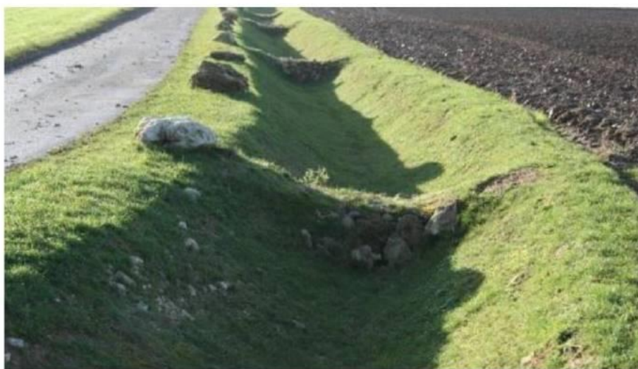
Illustration du principe de noue avec des redents
