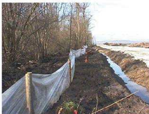
Clôture batraciens provisoire en phase chantier, cliché EGIS Environnement
