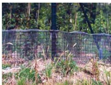
Photo 5 : Grillage soudé de type 6 adossé à la clôture grande faune de type 3. La partie supérieure est recourbée pour empêcher les animaux d'escalader et la partie inférieure est brochée au sol ou légèrement enterrée - Source : J. Carsignol (Cete de l'Est)
