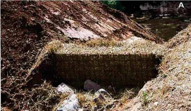
Exemple du filtre à paille, installé en travers d'un fossé. Ici le dispositif n'est pas suffisamment ancré dans les berges et pourrait favoriser des débordements sur les côtés.
