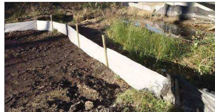
Figure 63 : Implantation de barrières amphibien en géotextile permettant d'éviter les déplacements des individus du cours d'eau vers le chantier © ETEN Environnement
