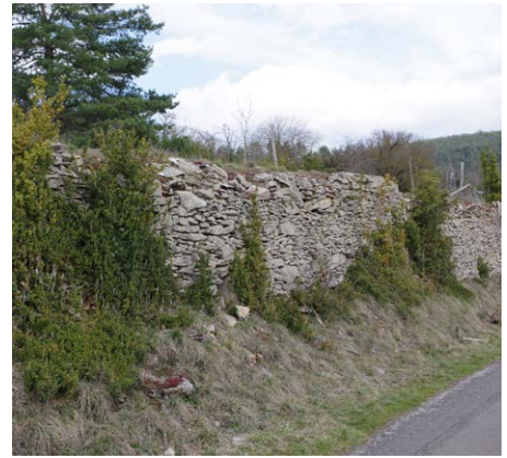
Murets de pierre sèche
