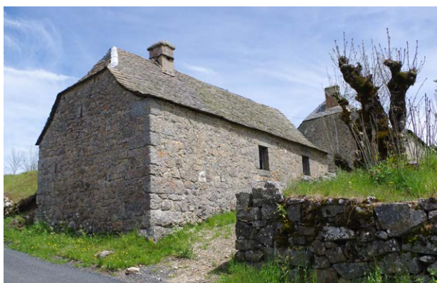
Bâtiments et murets en pierre sèche en granite
