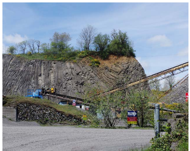
Front de taille de la carrière de Cantoinet révélant la couche de basalte et des structures d'orgues en éventail.
