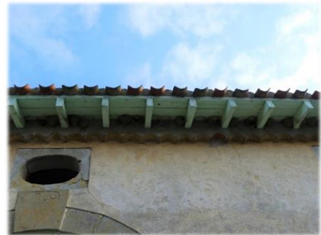
14. Suite, vue de la façade sud-ouest
