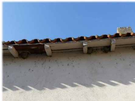
6. Nids, suite vue de la façade nord-est
