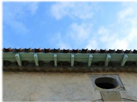
13. Suite, vue de la façade sud-ouest
