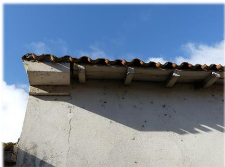
3. Nids, extrémité est de la façade nord-est (bât. 1)
