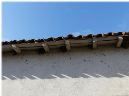
5. Nids, suite vue de la façade nord-est
