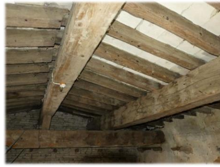
Vieux grenier et charpente à l'étage du bât. 1
