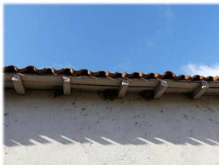
4. Nids, suite vue de la façade nord-est
