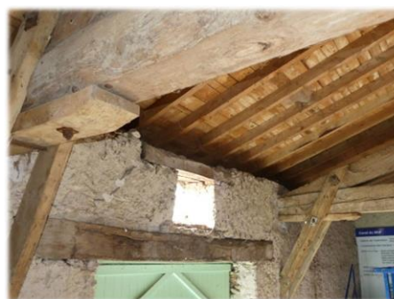
Vue de l'intérieur du bâtiment 2, non occupé par l'Hirondelle rustique
