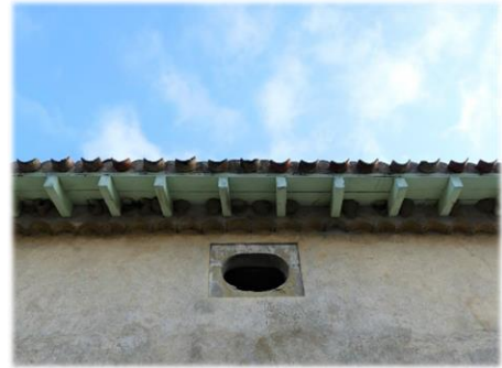
12. Suite, vue de la façade sud-ouest
