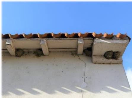
7. Nids, extrémité nord de façade nord-est
