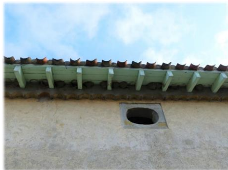
15. Suite, vue de la façade sud-ouest
