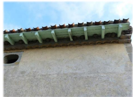
16. Fin, vue de la façade sud-ouest
