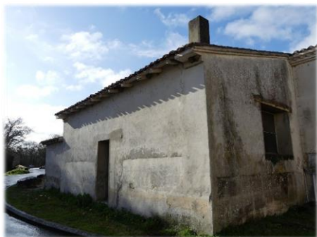
1. Façade abritant une dizaine de nids d'Hirondelle de fenêtre (orientation NE)
