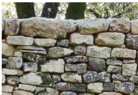
Muret pierres sèches à double parement
