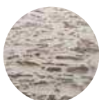
Enduit à pierre-vue
