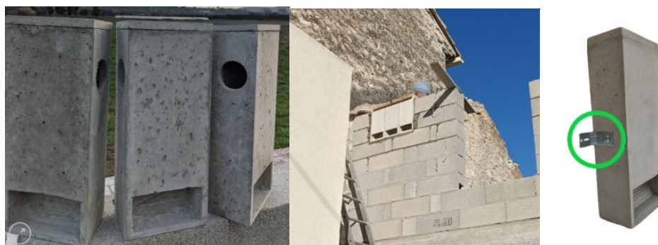
Figure 25 : Gîtes artificiels communicants à encastrer (à gauche) - Exemple de gîtes encastrés (au centre) - Gîte à fixer en façade (à droite)
