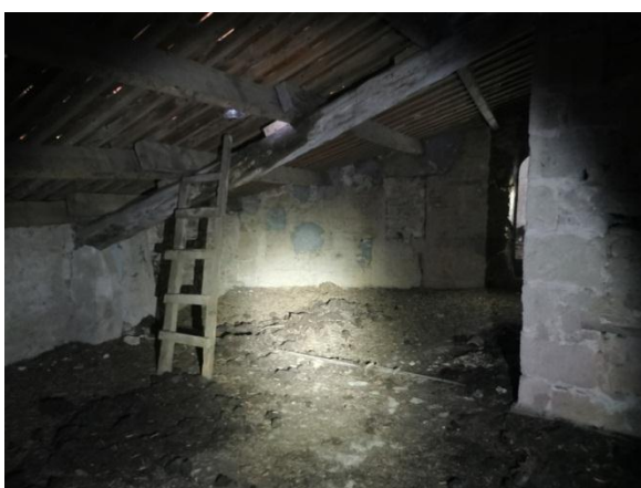
Figure 11: Grenier du Presbytère
