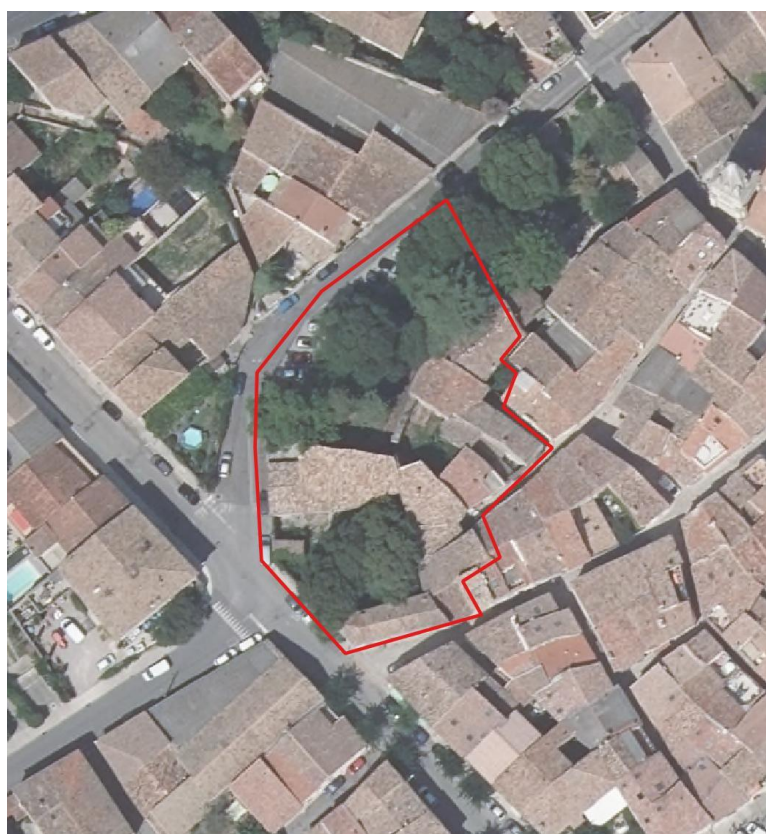
Saint André de Sangonis - Médiathèque et logement collectif
