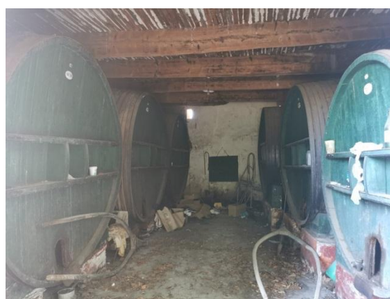
Figure 18 : Hangar à cuves sous Grenier
