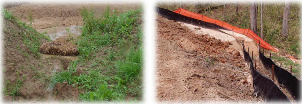
Filtre à paille (photo ECTARE) et barrière à sédiments (AFB)
