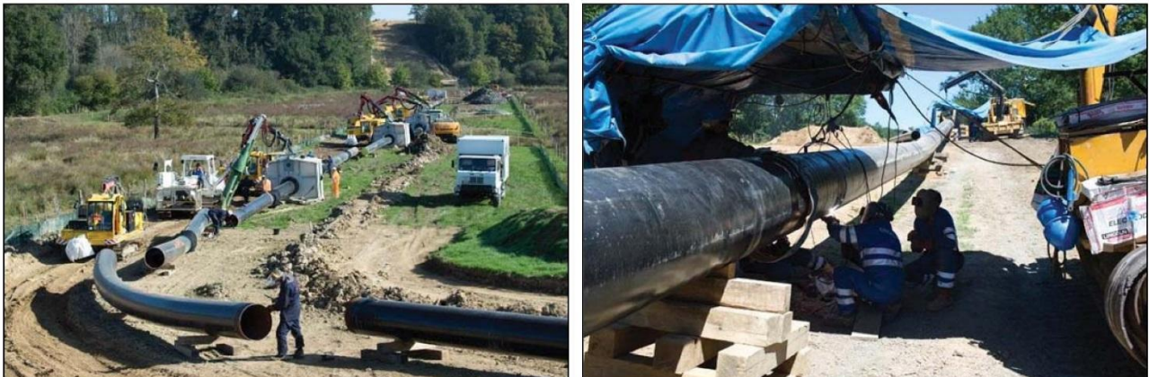
Figure 13. Photos – Cirque de soudure de ligne composé de plusieurs cabines de soudage (Source : TEREGA)
