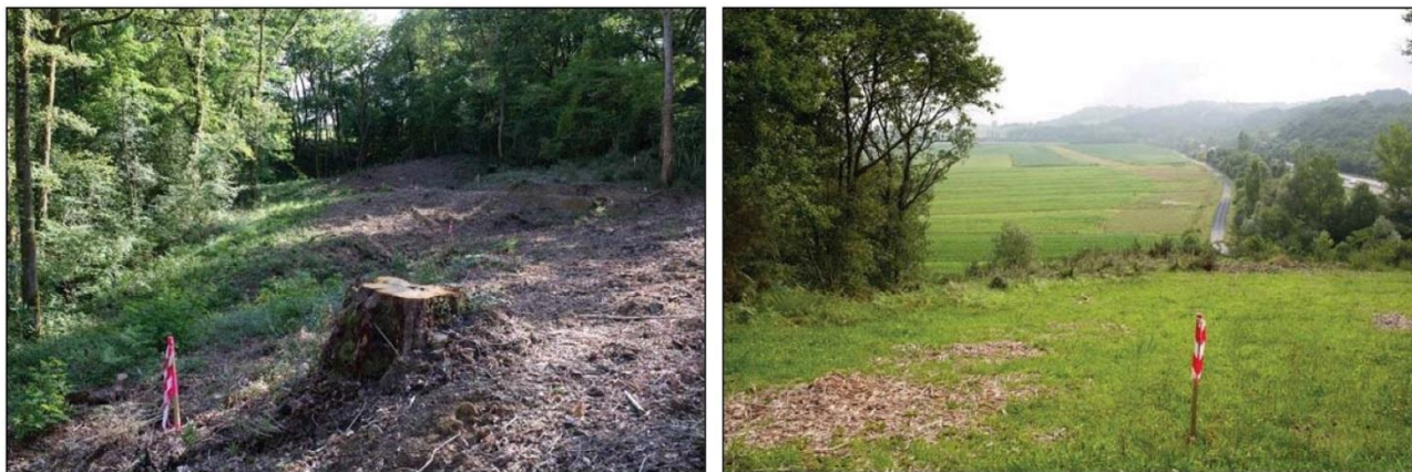
Figure 6. Photos – Piquetage des emprises après déboisement et piquetage de l'axe de la tranchée (Source : TEREKA)
