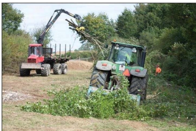
Figure 7. Photos – Ouverture des emprises en zone boisée et en zone de prairie (Source : TEREGA)
