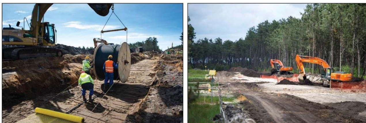
Figure 15. Photos – Remblaiement (Source TEREKA)
