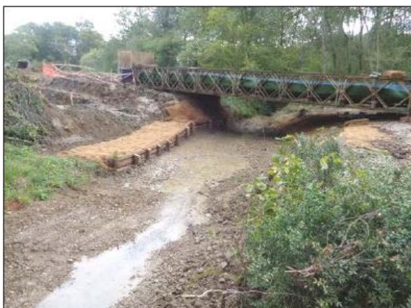
Figure 20. Pont du génie civil/pont Bailey (Source : Chantier Artère de l'Adour)
