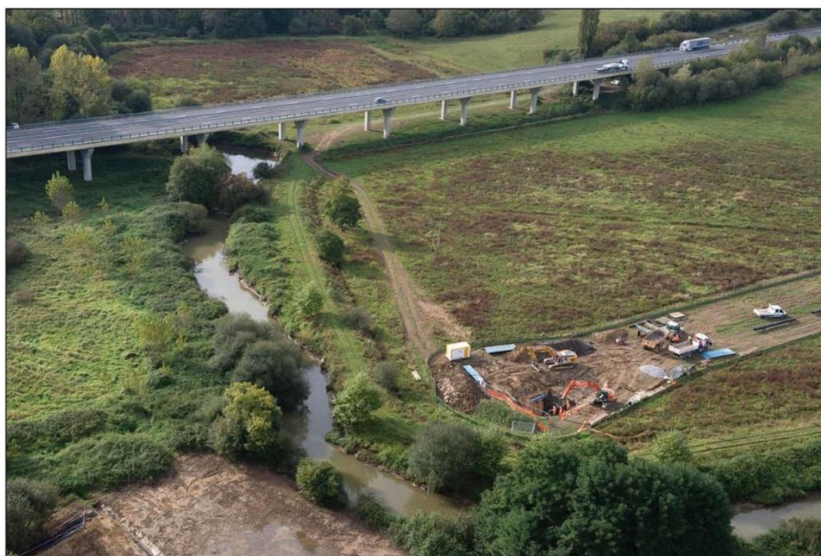
Figure 21. Photo – franchissement d'un cours d'eau en sous-œuvre (Source TEREGA)
