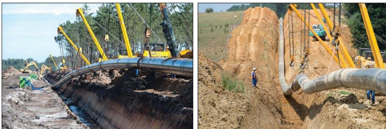
Figure 14. Photos – Tronçon de canalisation mis en fouille de ligne à l'aide de plusieurs side-booms (Source : TEREGA)
