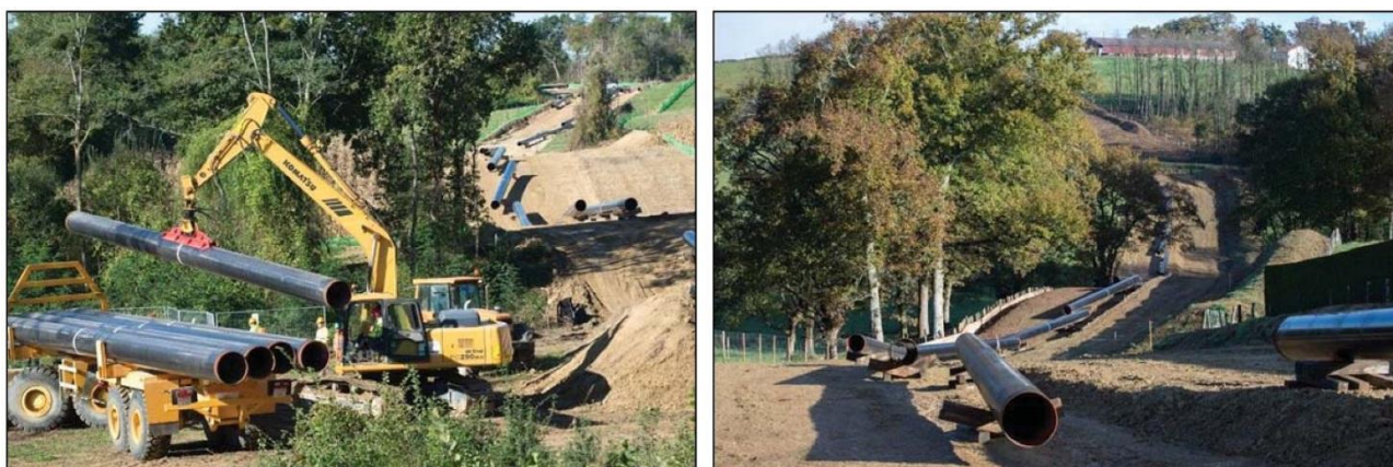
Figure 11. Photos – Acheminement des tubes sur le chantier et bardage sur la piste (Source : TEREGA)
