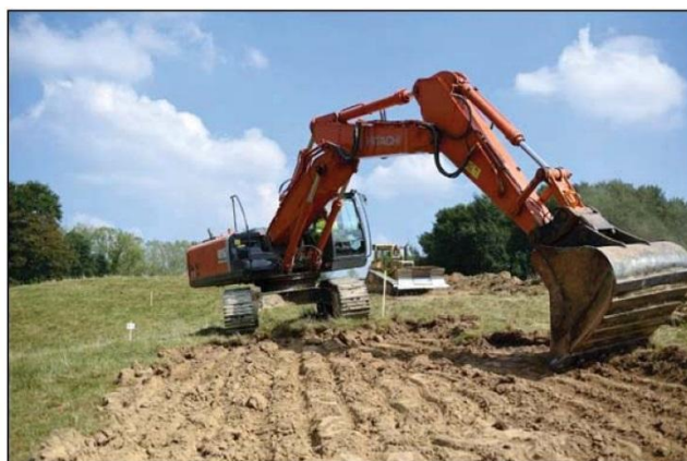
Figure 7. Photos – Ouverture des emprises en zone boisée et en zone de prairie (Source : TEREGA)
