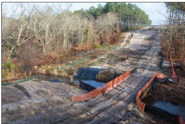
Figure 9. Photos – Renforcement de piste par rondins de bois et aménagement de piste autour d'une zone écologique sensible (Source : TEREGA)
