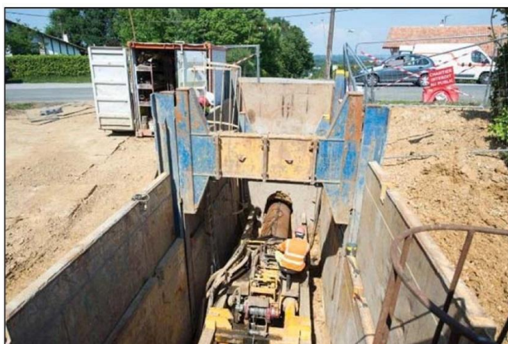
Figure 16. Photo – franchissement d'une route en sous-œuvre (Source TEREGA)
