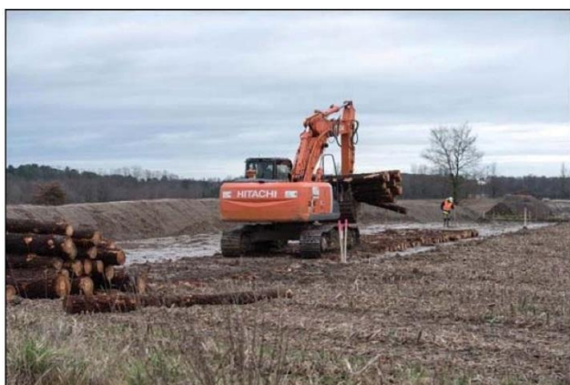
Figure 9. Photos – Renforcement de piste par rondins de bois et aménagement de piste autour d'une zone écologique sensible (Source : TEREGA)
