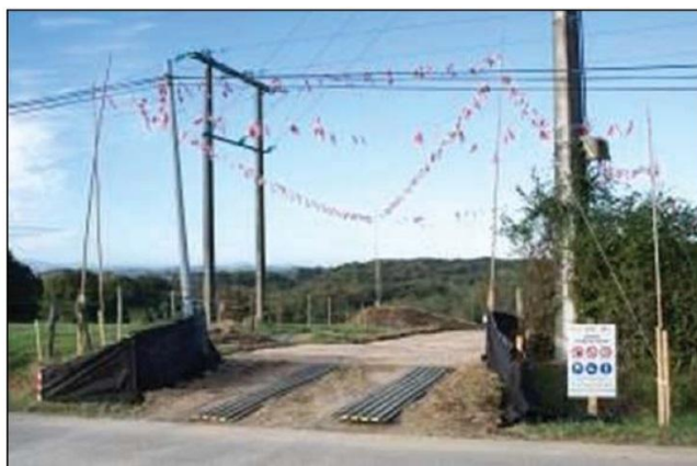
Figure 8. Photos – Aménagement d'un franchissement de ruisseau par gaine et balisage sous une ligne électrique (Source : TEREGA)
