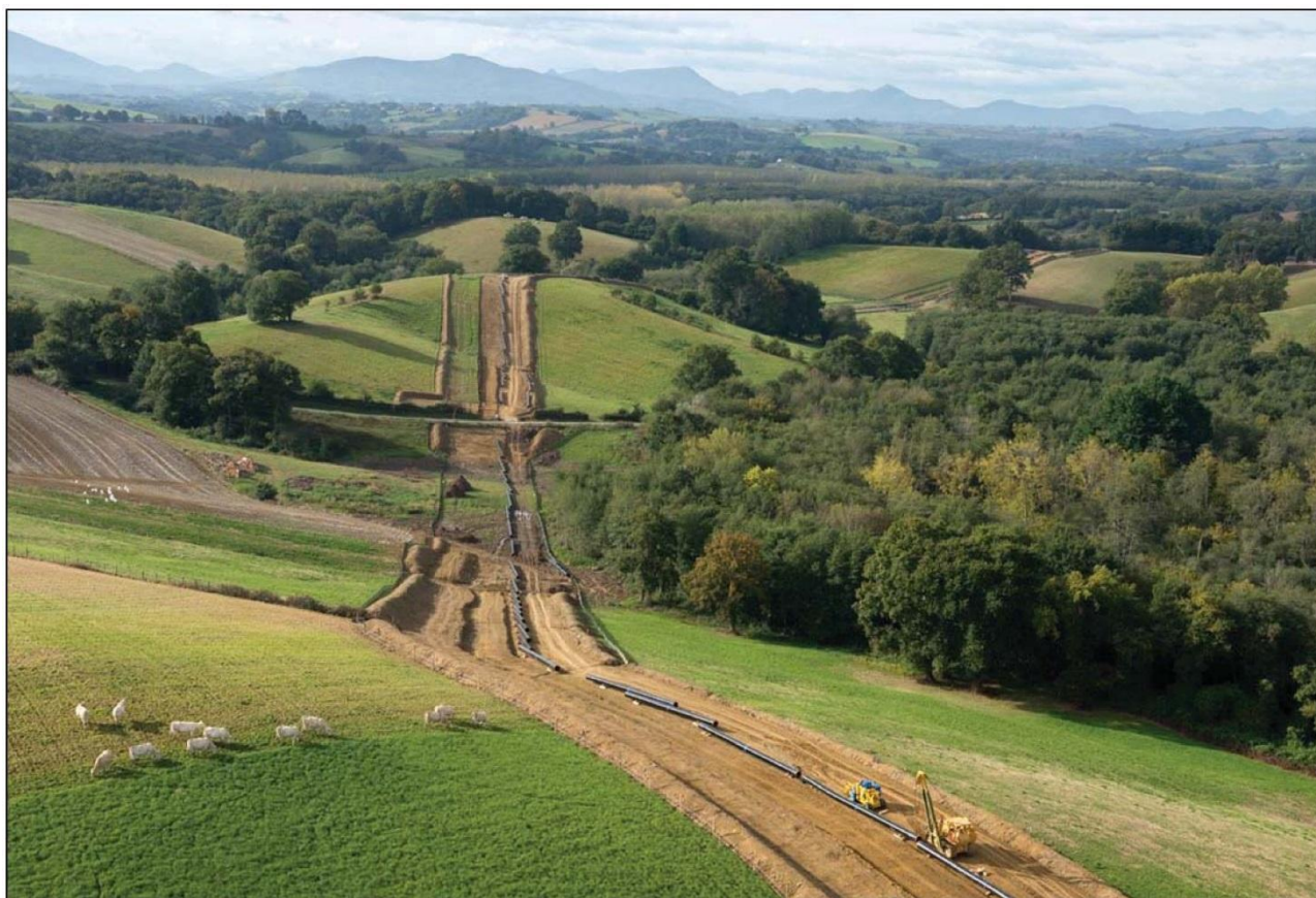
Figure 5. Photo – Exemple de piste de chantier (Source : TEREGA)
