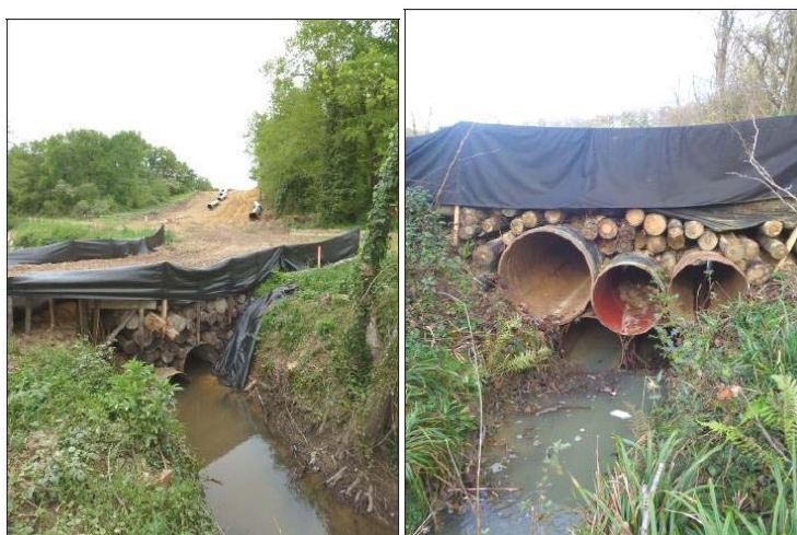
Figure 18. Gainés métalliques recouvertes d'un platelage en rondins de bois (photo : TEREKA)
