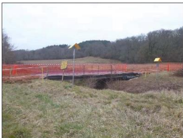
Figure 19. Pont composé d'un assemblage de plusieurs structures métalliques (Source : chantier Artère du Béarn)
