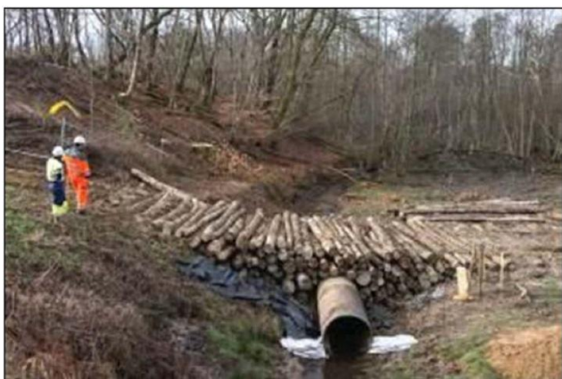
Figure 8. Photos – Aménagement d'un franchissement de ruisseau par gaine et balisage sous une ligne électrique (Source : TEREGA)
