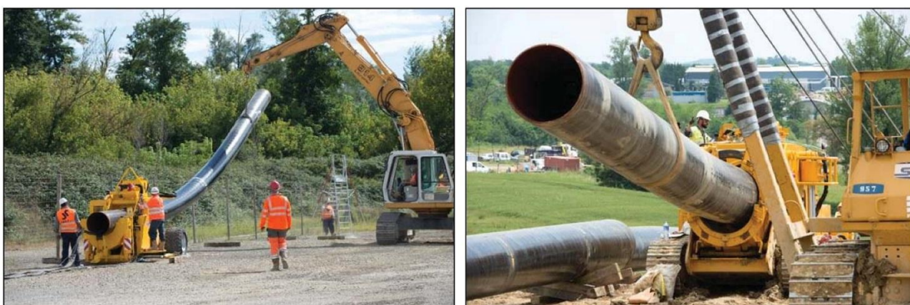
Figure 12. Photos – Exemples de tubes en cours de cintrage (Source : TEREGA)
