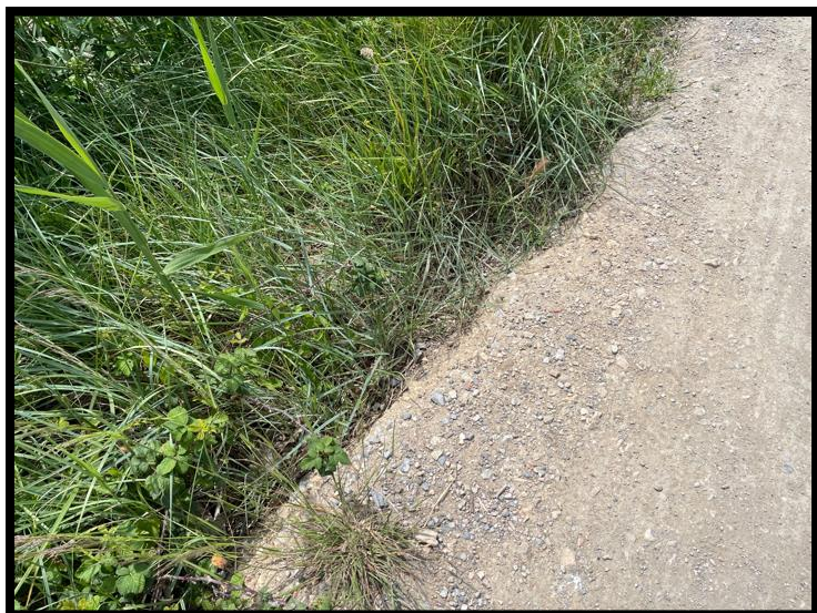
Illustration des prémices de décrochage du chemin de halage à divers endroits du linéaire objet du projet en cours.
