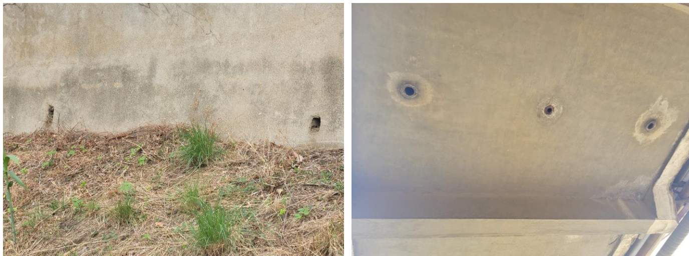
Figure 36 : Cavités dans un mur (à gauche) et sous le tablier du pont du Puig Del Mas (à droite) sur la zone d'étude
