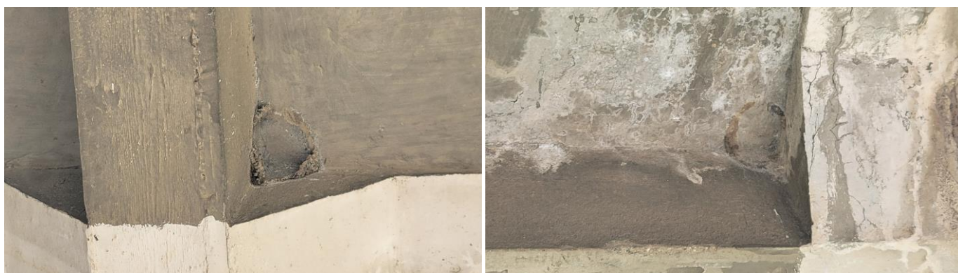
Figure 62 : Exemple de nids dégradés à l'état d'amorce observés sous le pont objet des travaux.
