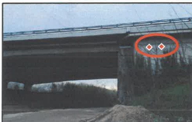
Gîtes intérieurs fixés dans les caissons au niveau des voussoirs sur piles :
