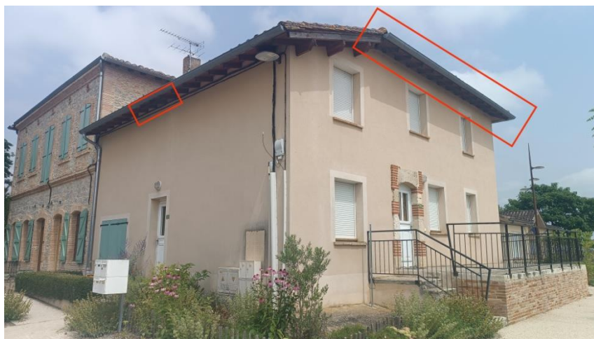
Figure 3 : Bâtiment ciblé par les travaux, les zones grillagées sont cadrées de rouge (V.Aziosmanoff/LPO Occitanie)
