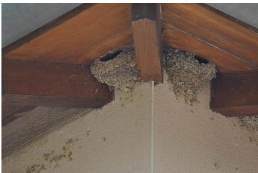
Figure 4 : Bâtiment ciblé par les travaux et zone grillagée (LPO Occitanie)
