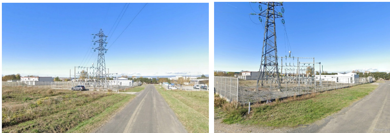
Figure 1 : Vues sur le poste source de Viguié, chemin de Maquens
