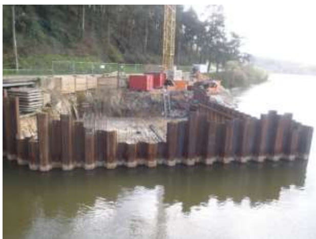
Travaux de redimensionnement de l'évacuateur de crue (EVC) Barrage de la Grande Chaussée (22) ©DREAL Bretagne - Olivier ORHANT – mars 2015
