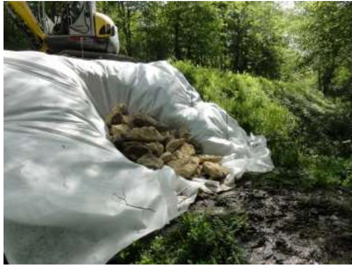
Travaux d'urgence sur un renard hydraulique Travaux provisoires en attendant des travaux définitifs validés par un bureau d'études agréé © DREAL Hauts-de-France – Boris KOMADINA
