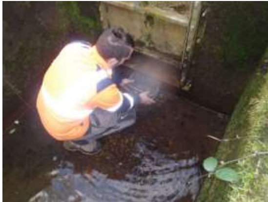
Mesure d'un débit de fuite de la vidange de fond – Barrage de la Verte Vallée (22) ©DREAL Bretagne Oliver ORHANT – octobre 2021
