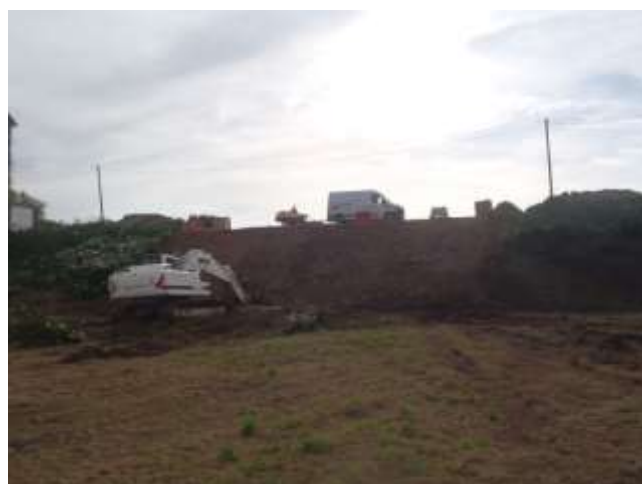
Travaux de décapage du parement amont avant la pose d'une géogridle recouverte de terre végétale suite à l'EISH – Barrage de Beffou (22) ©DREAL Bretagne - Olivier ORHANT - octobre 2023
