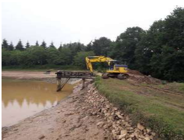
Reprise du profil du barrage ⇒ travaux substantiels
