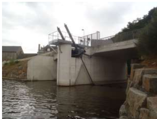
EVC après les travaux de redimensionnement Barrage de la Grande Chaussée (22) ©DREAL Bretagne - Olivier ORHANT – juin 2019
