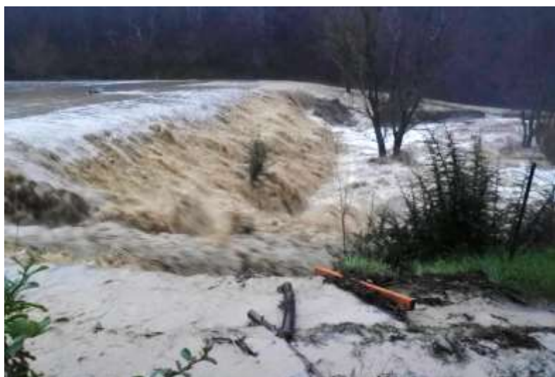
Surverse du barrage de Chalabre (11) le 22 janvier 2020 (le barrage a été totalement arasé depuis cet événement) © INRAE – Anthony Mouyeaux
