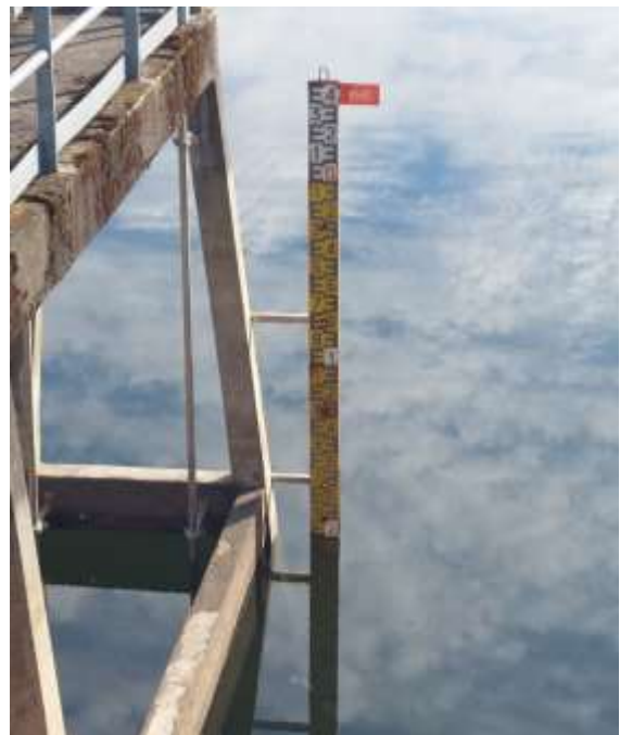
Échelle limnimétrique du barrage de la Crouzille (87) avec repérage de la cote des plus hautes eaux (PHE) © PoNSOH – Hélène CHITRY
