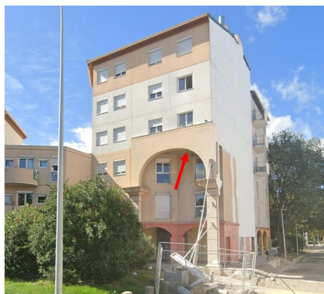
Surplombs favorables à l'installation de nids d'hirondelle rustique Rue Cheng du/place de Chine
