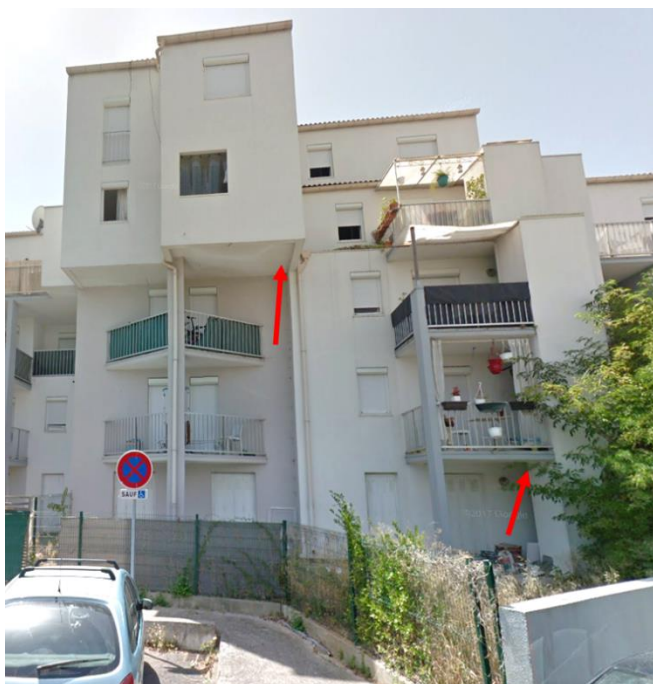
Surplombs favorables à l'installation de nids d'hirondelle rustique Place St Simon
