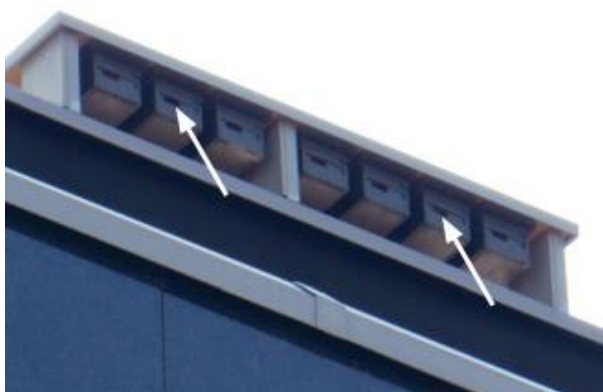
Nichoirs posés sur une toiture terrasse
