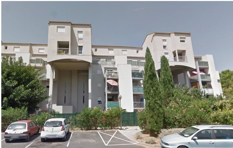
Maintien des 3 porches de grande hauteur favorables à l'installation des hirondelles rustiques
