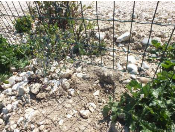
Clôture surélevée d'environ 10 cm par rapport au sol
