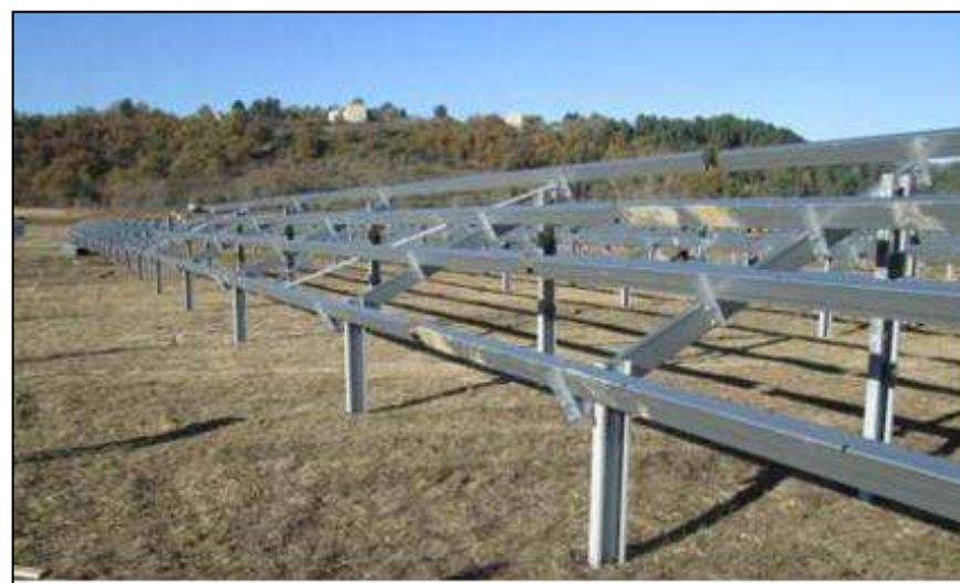
Figure 5 : Exemple de structures porteuses (source : CNR)
