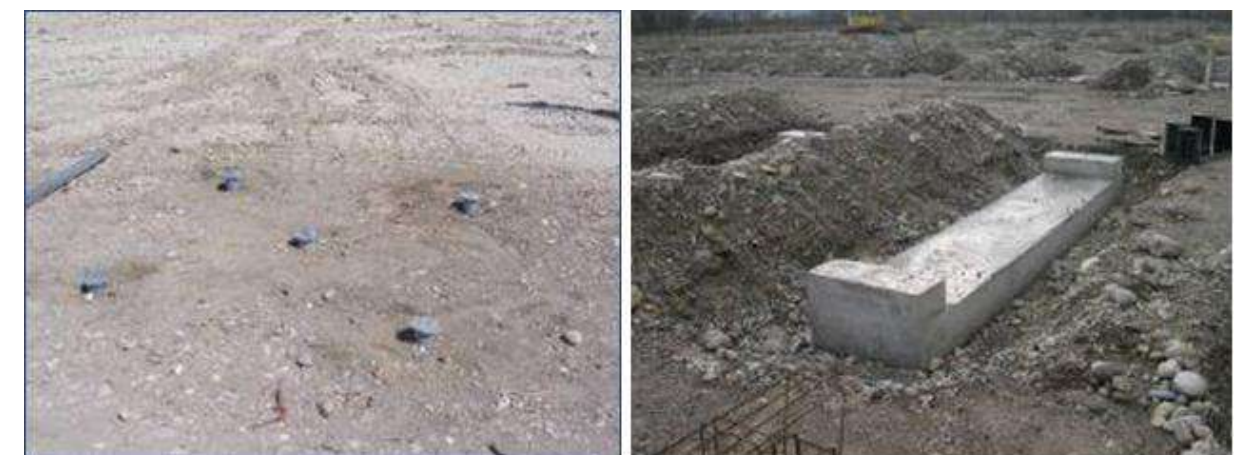
Figure 7 : Tête de pieu vissé et longrine (plot béton) (source : CNR)
