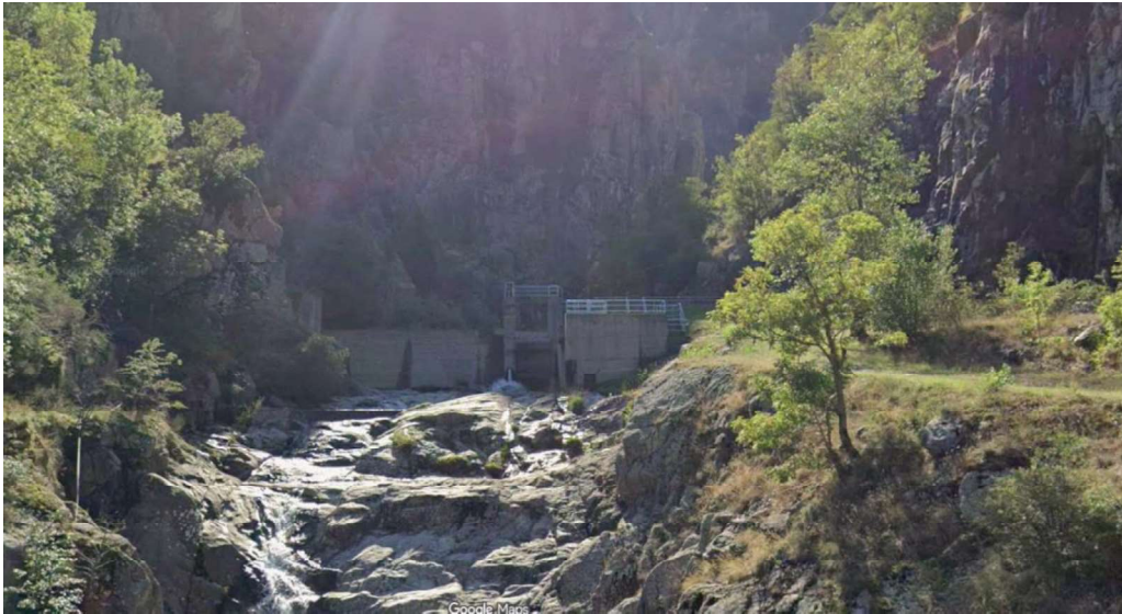
Figure 5 : Vue sur la prise d'eau depuis la route départementale (source : google.maps)
