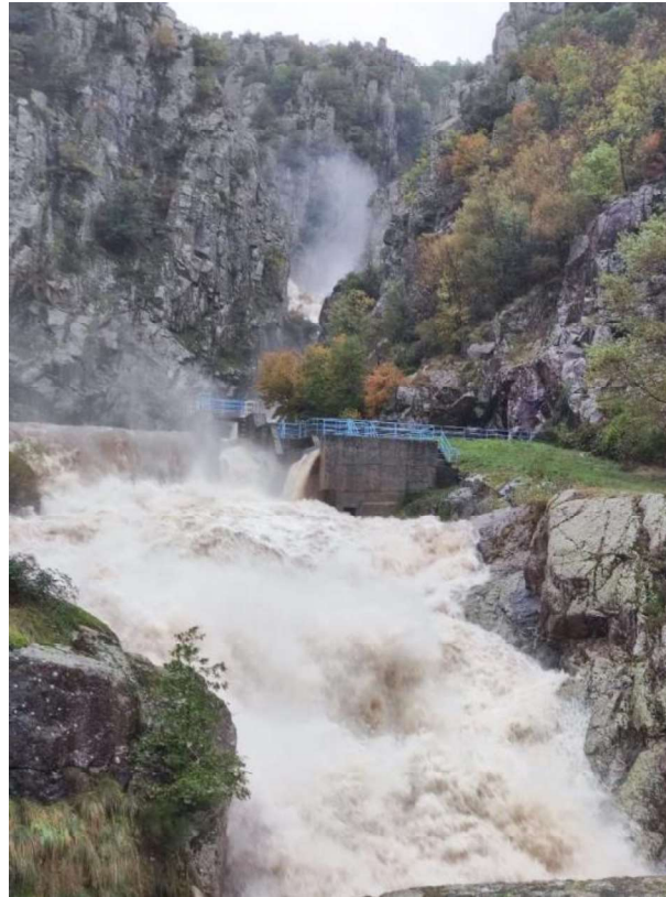
Figure 13 : Photo de la crue d'octobre 2024 (source : EDF)
