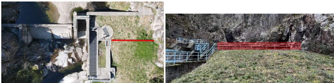
Figure 9 : Garde-corps à déposer pour la création de la piste d'accès
