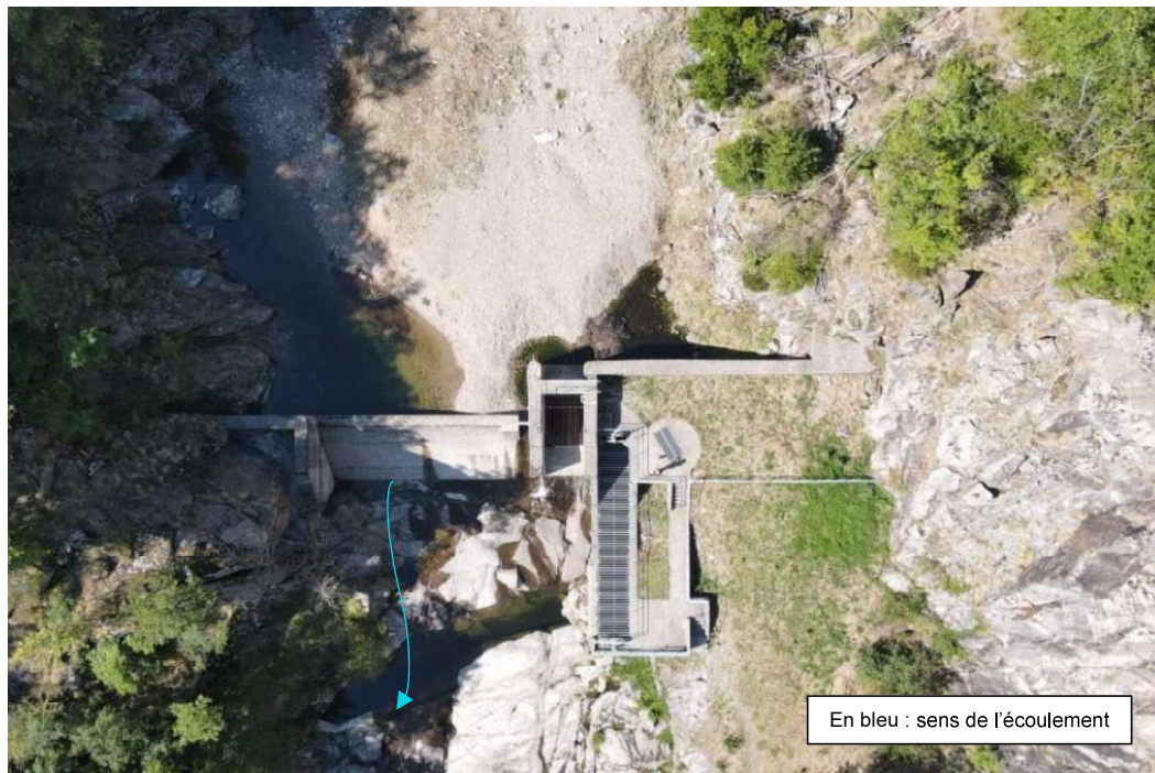
Figure 4 : Photo aérienne en plan de la prise d'eau de Fustugères (Photo prise par drone en 2022 – Source : EDF)
