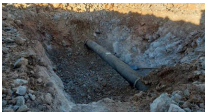
Fouille réalisée sur l'ouvrage existant DN250 Narbonne - Clairac
