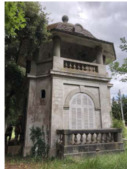
Pavillon réalisé en béton sur vocabulaire d'architecture classique
