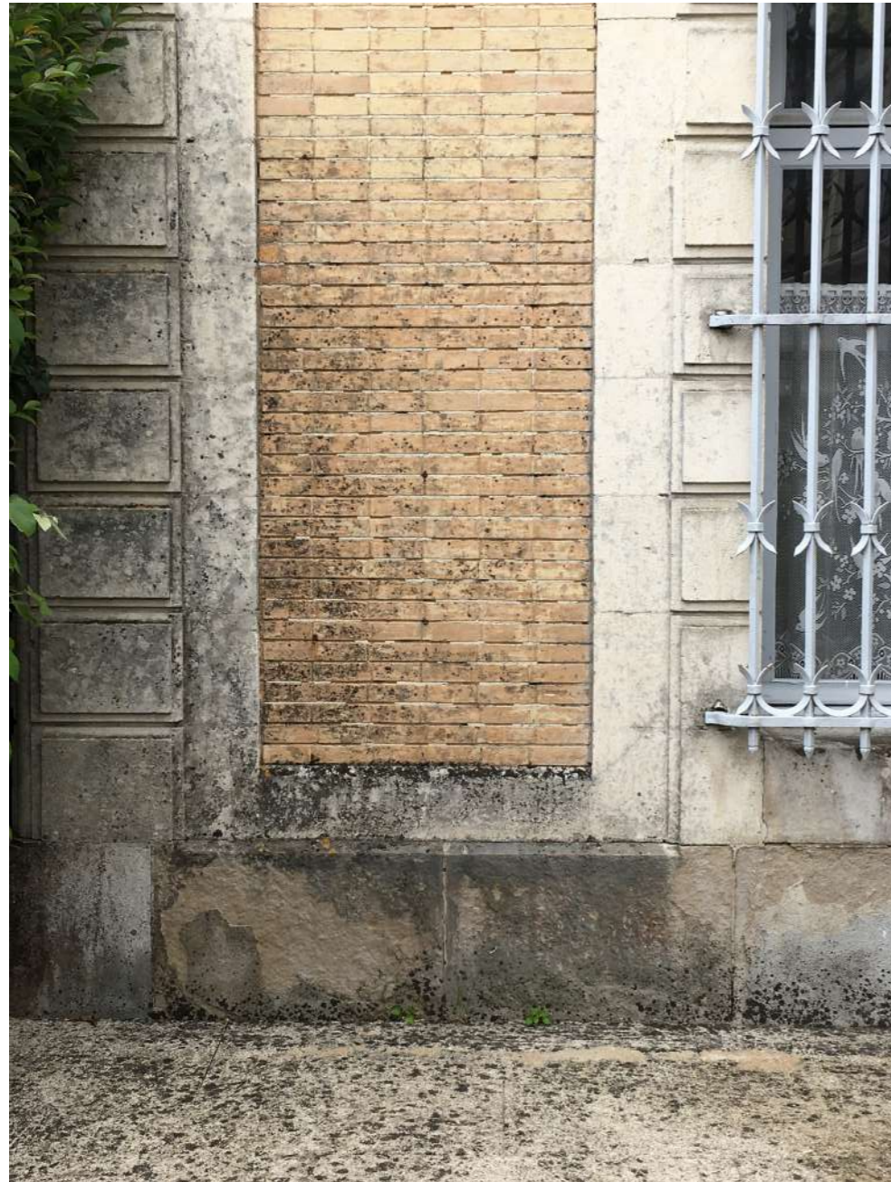
Paroi de pierre calcaire ocre avec table brique jaune appareillé à l'échelle en creux
