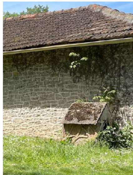
Maçonnerie en opus incertum à joint saillant
