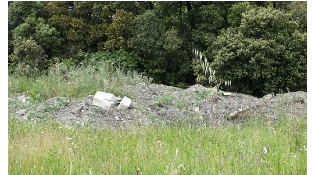
Déblais en attente, effet «chantier»
