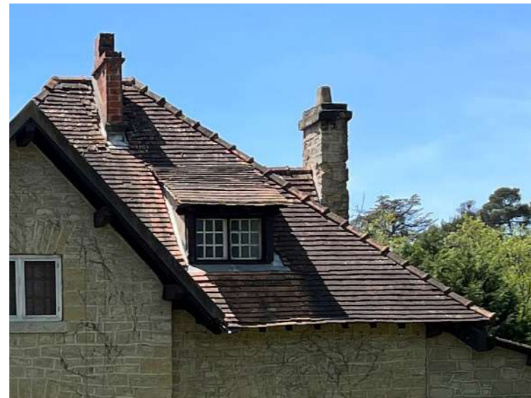
Couverture en tuile plate
