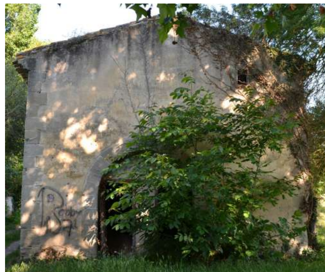
Enduit ton sable avec chaînage harpée en pierre vue
