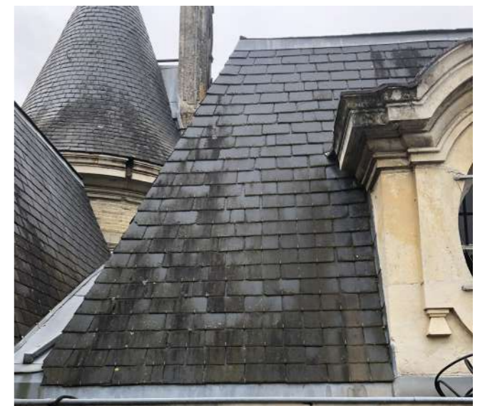
Couverture en ardoise
