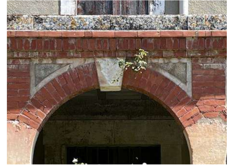
Corniche briques appareillées verticales
