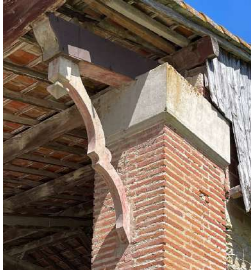
Débord de toiture sur aisselier
