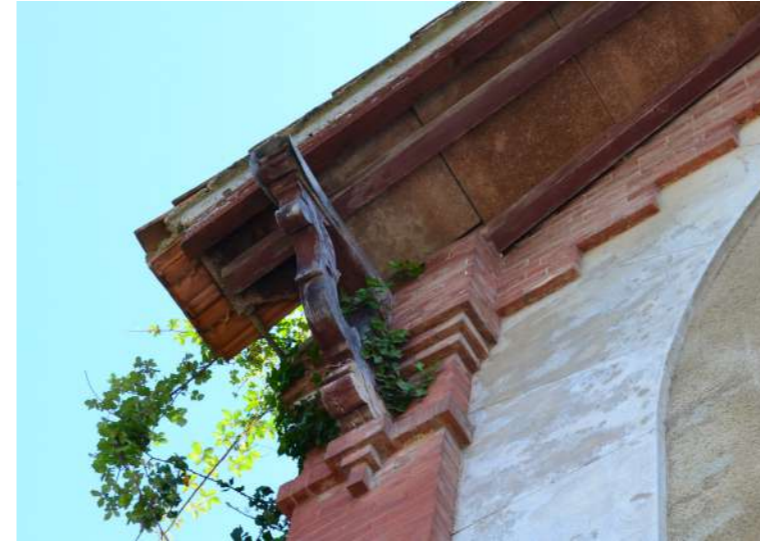
Débord de toiture sur aisselier
