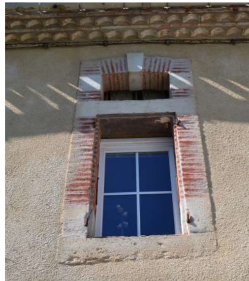
Fenêtre partitionnée par une traverse pierre par pierre gafonnières sur chambranle brique saillant pour arrêt d'enduit
