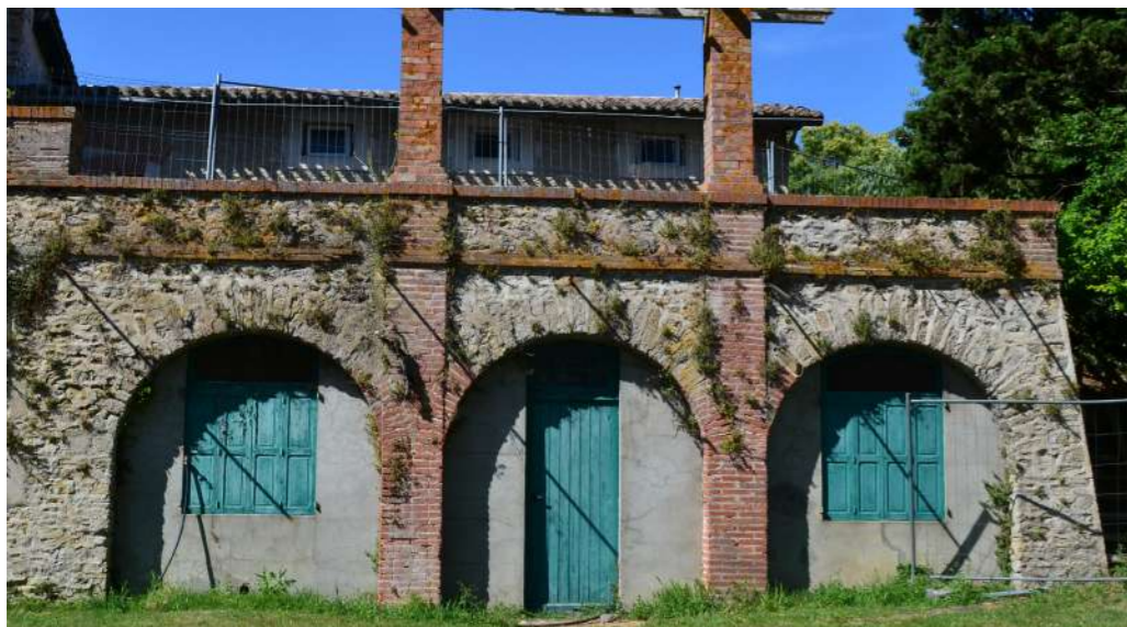
Arcades triple en moellon avec au centre des piliers brique
