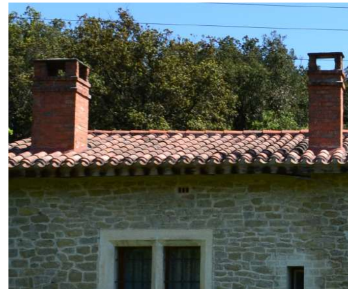
Couverture en tuile canal
