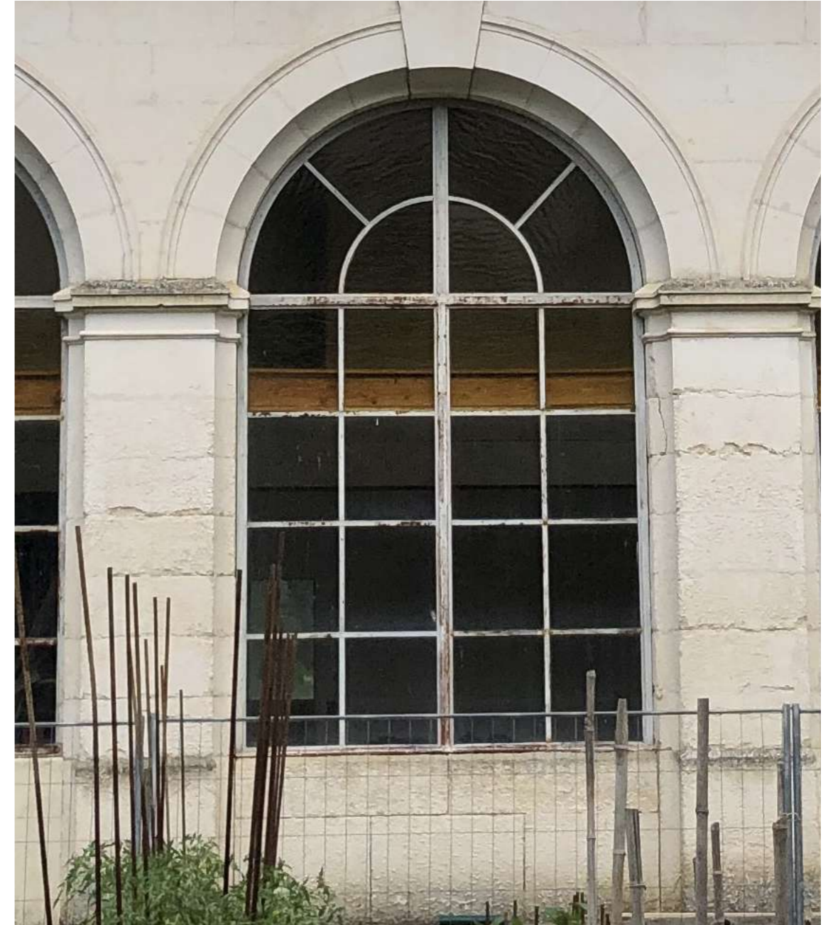
Fenêtre à petit carreaux sous imposte cintrée
