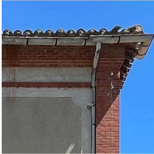
Entablement avec architrave, frise et corniche simples
