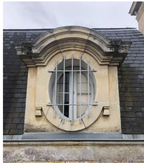
Oculus pierre sous fronton cintré avec chambranle à crosvsette
