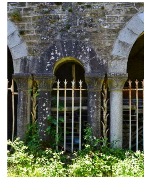
Arcature rythmique de cintres pierre sur colonnes granit
