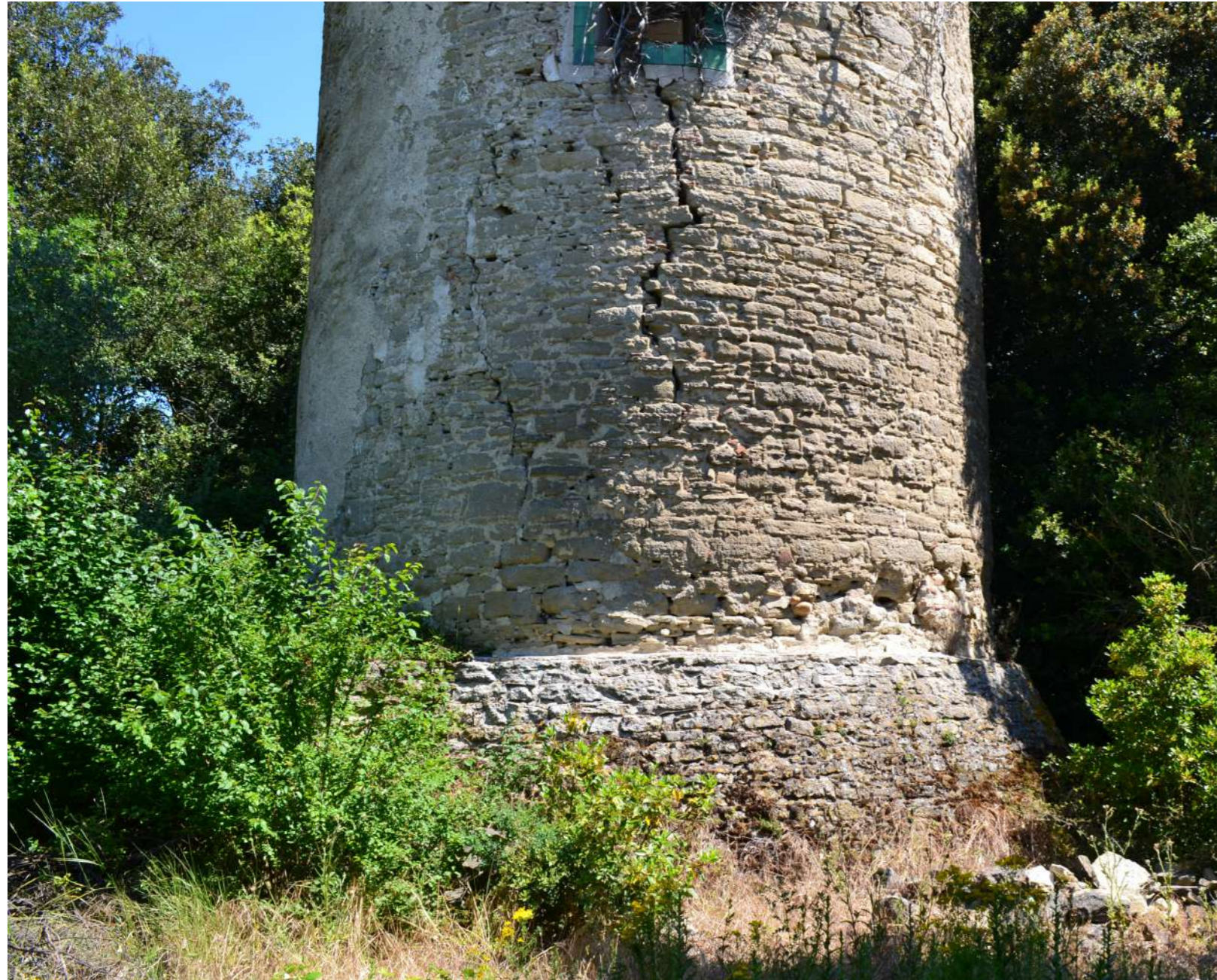
Soubassement en moellon avec fruit
