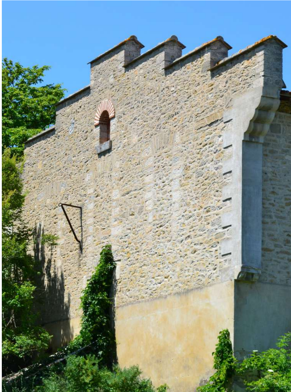
Paroi en maçonnerie de moellons avec soubassement enduit ocre
