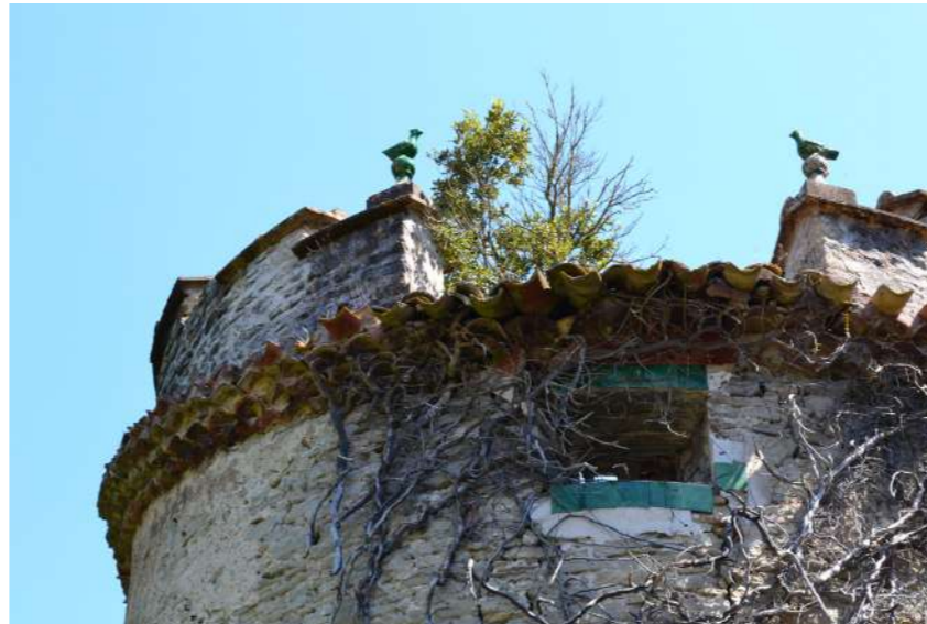
Génoise saillante à trois rangs avec tuile courante au débord marqué. Pigeons sur sphère cuite vernissée verte
