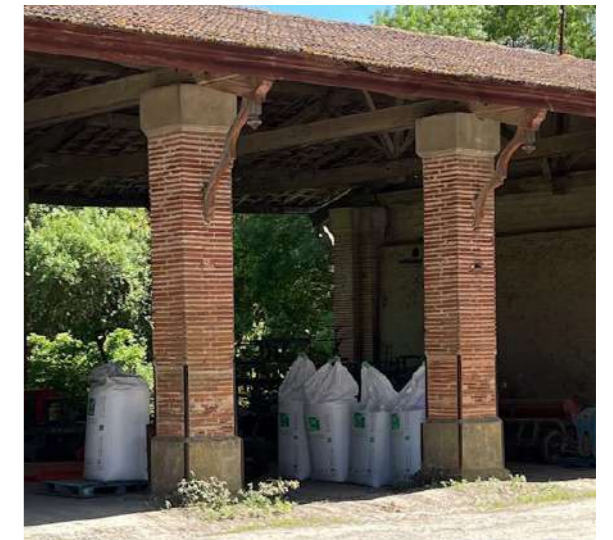
Pilier de grange brique avec base et chapiteau pierre
