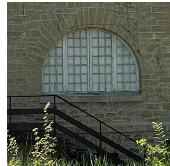
Plein cintre pierre sur paroi en opus-incertum, menuiserie à petits bois
