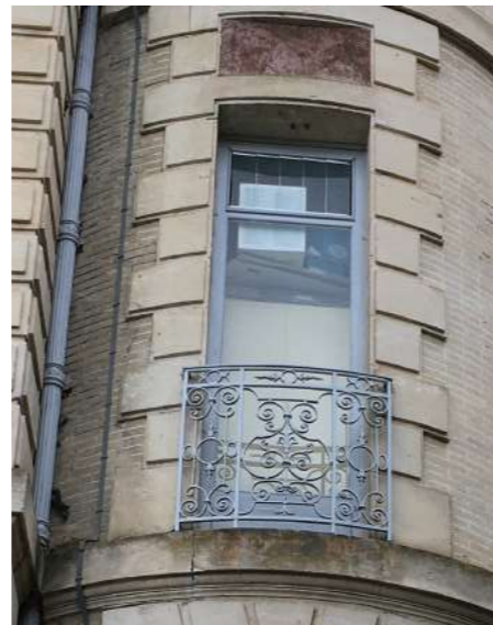
Fenêtre en clair de vitre avec imposte simple
