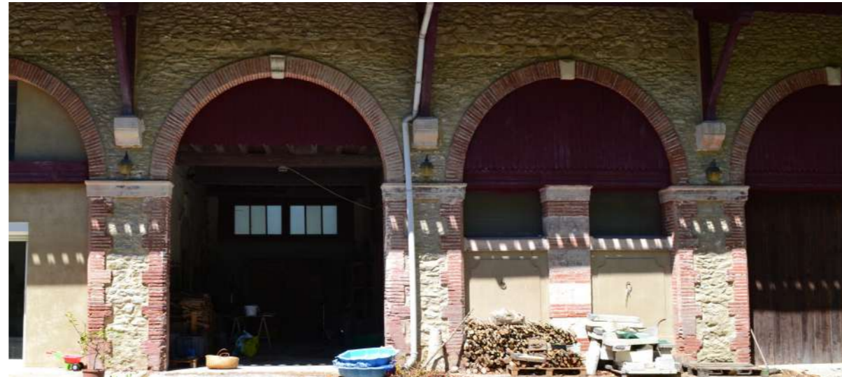
Pilier pierre avec chaînage d'angle en brique avec harpage
