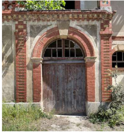
Arc plein cintre avec marquage de clé et sommiers
