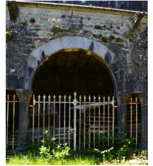
Arc plein cintre pierre régulier sur colonne néo-romane
