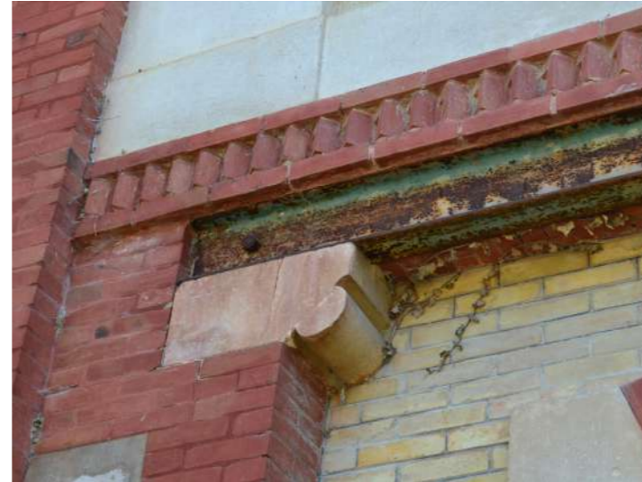
Corniche de brique rouge appareillée à 45°
