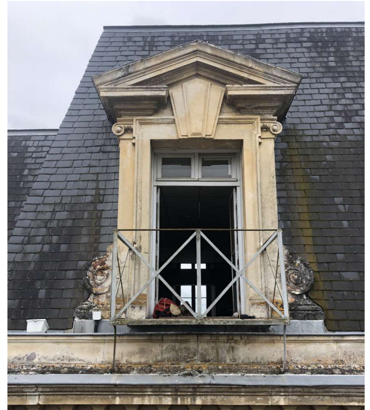
Fenêtre sur toit en pavillon, couverte par plate bande avec clé monumentale passante sur fronton triangulaire interrompu avec chambranle à crosvsette flanquée de piliers à chapiteau ionique à volute
