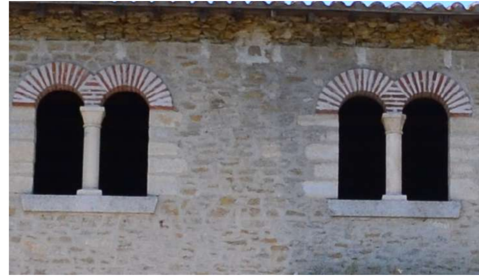
Fenêtre géminée à arc brique portant sur colonnette pierre calcaire avec chambranle irrégulier harpée et appui granit débordant
