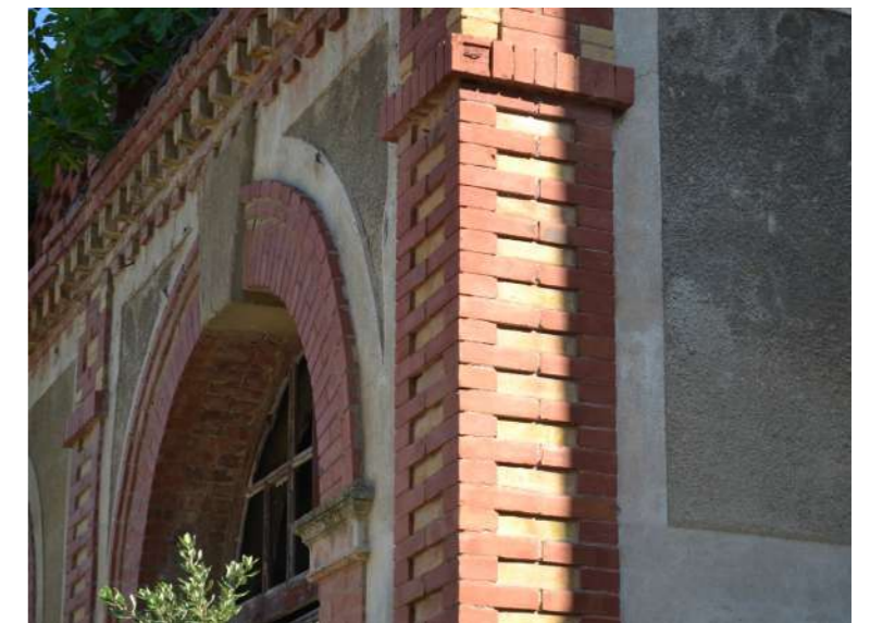
Pilier d'angle brique et enduit avec motif d'échelle
