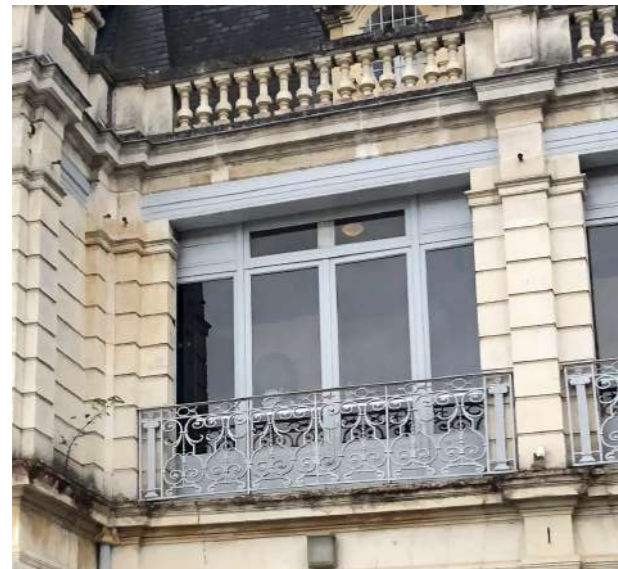
Fenêtre à grands carreaux avec imposte vitrée
