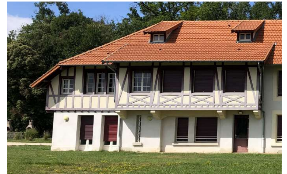
Paroi béton avec imitation pans de bois
