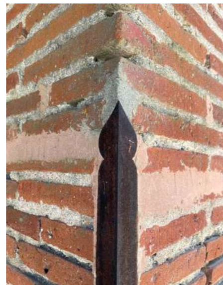
Renfort d'angle métal sur pilier brique
