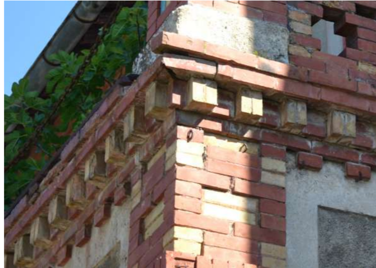
Corniche brique rouge à modillon de brique ocre
