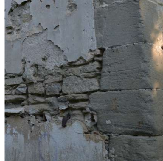
Mur de maçonnerie de moellon enduit avec chaînage d'angle assisé
