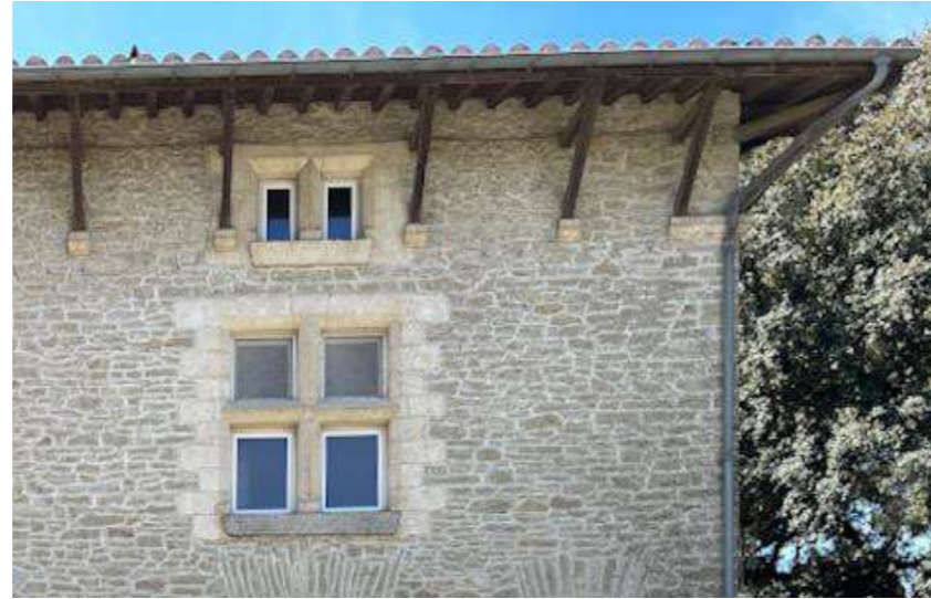
Débord de toiture sur aisselier
