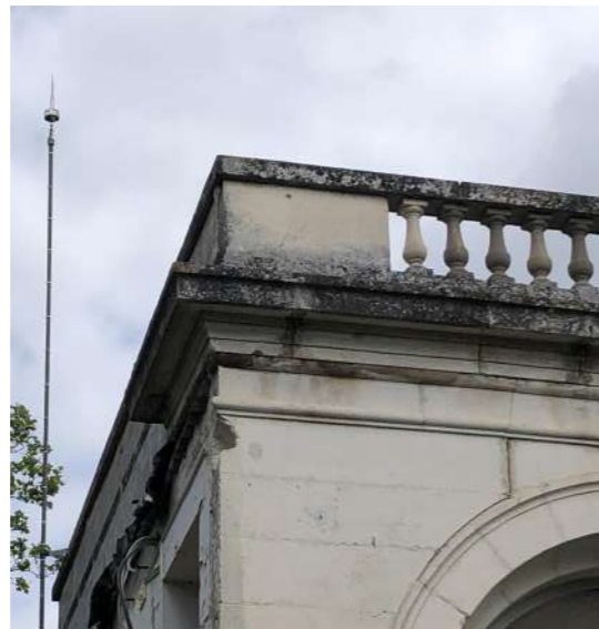
Entablement à corniche saillant et attique à balustres en poire
