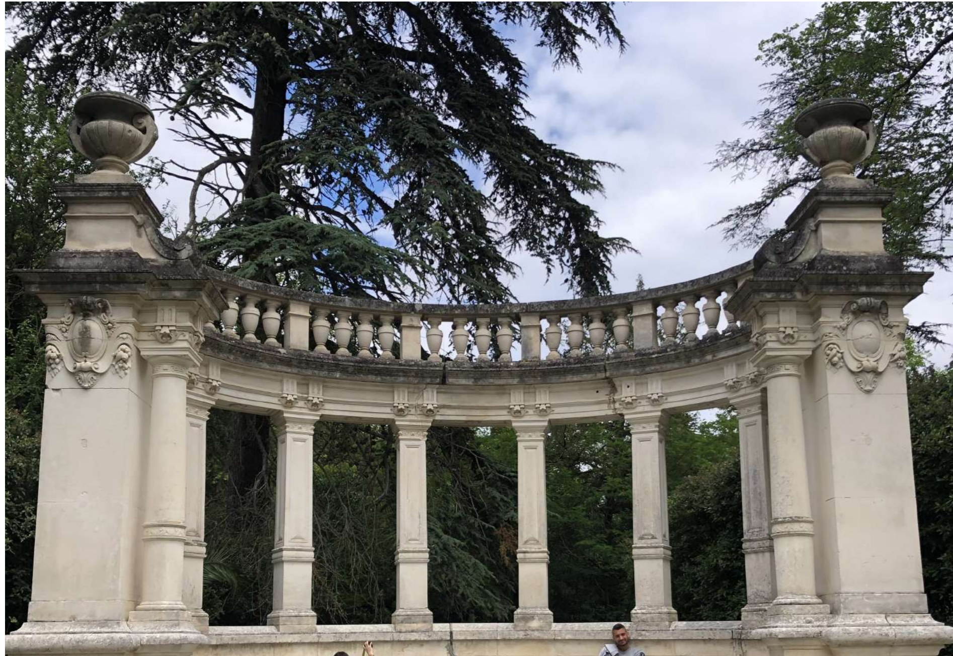
Balustrade d'attique pierre sur entablement à diglyphes
