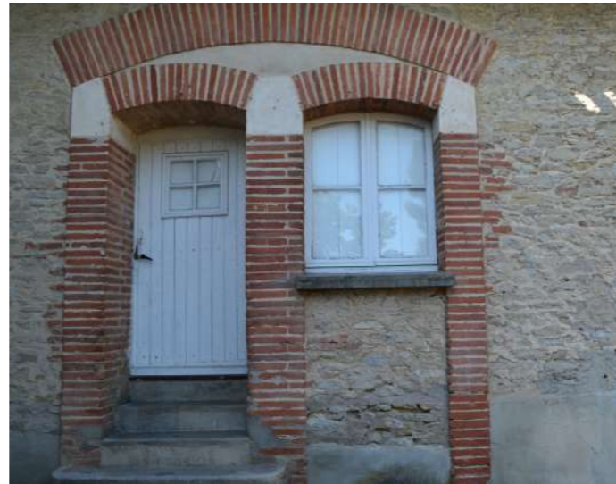
Double arcade sous arc de décharge brique
