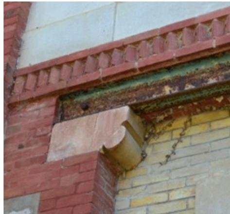
*Corniche brique rouge à modillon de brique ocre ; Corniche de brique rouge appareillée à en dent d'engrenage.*
