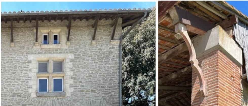
Débord de toiture sur aisselier ; Débord de toiture sur aisselier
