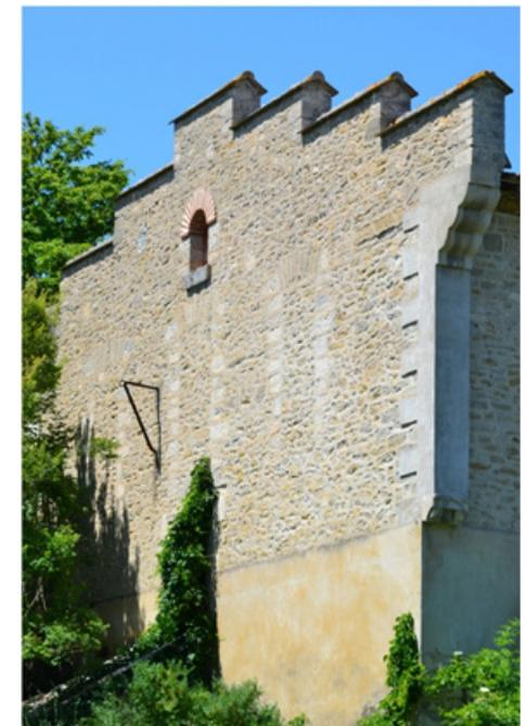
*Paroi de pierre calcaire ocre avec table brique jaune appareillé à l'échelle en creux ; Paroi en maçonnerie de moellons avec soubassement enduit ocre.*
