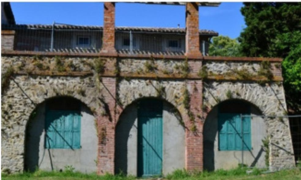
*Triple arcade en maçonnerie de moellons de pierre, scandées de piliers en brique*
