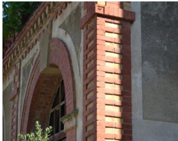
*Pilier d'angle brique et enduit avec motif d'échelle*
