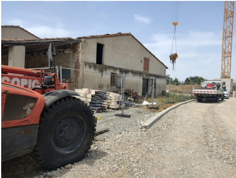
Figure 17 : Travaux autour de la grange (2022) © ETEN environnement
