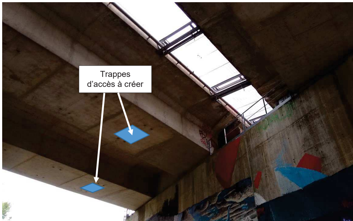
Figure 8 : Visualisation des trappes à créer sur le PI318 (source : Arcadis MOE PRO, 01/10/2020)
