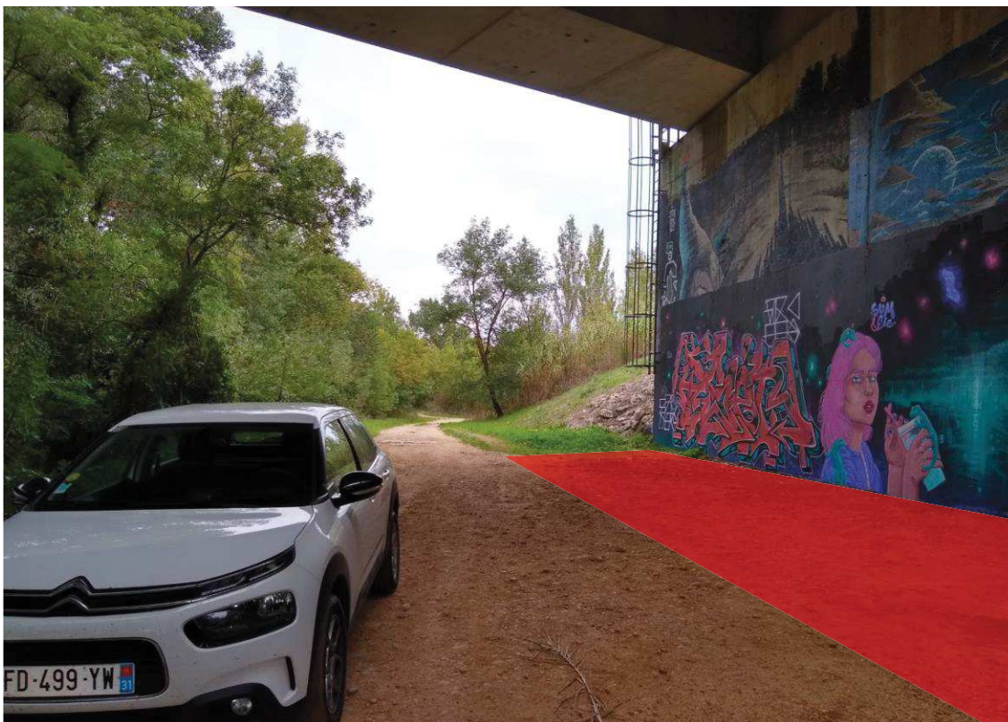
Figure 19 : Localisation de la zone pour entreposer temporairement des éléments en rive gauche en dehors de la période de hautes eaux (source : Arcadis MOE PRO, 01/10/2020)
