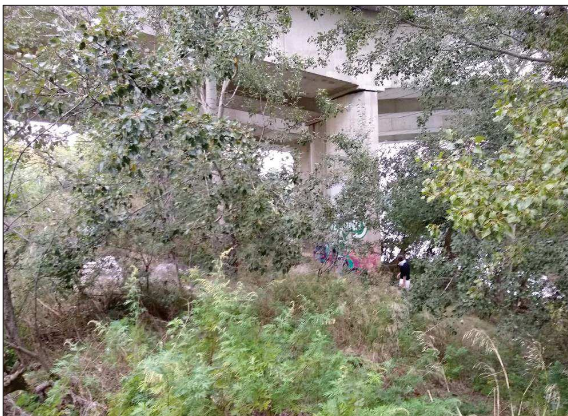
Figure 47 : Visualisation de l'habitat « Ripsisylve Frêne à petites feuilles » en rive droite du Gardon, où une rampe d'accès aux piles P2 devra être mise en place (source : Arcadis MOE PRO, 01/10/2020)
