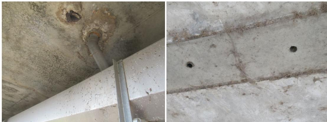
Figure 25 : A gauche présence de guano sur le caisson métallique situé sous le drain ; à droite drain entre les caissons favorable.
