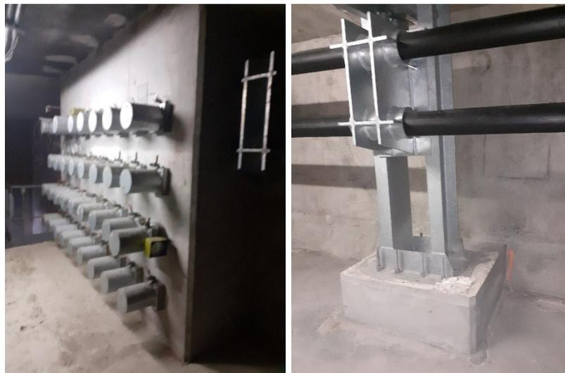
Figure 34 : Illustration d'un massif d'ancrage et d'un déviateur de câbles de précontrainte à mettre en place à l'intérieur des caissons (Photo : Naturalia)
