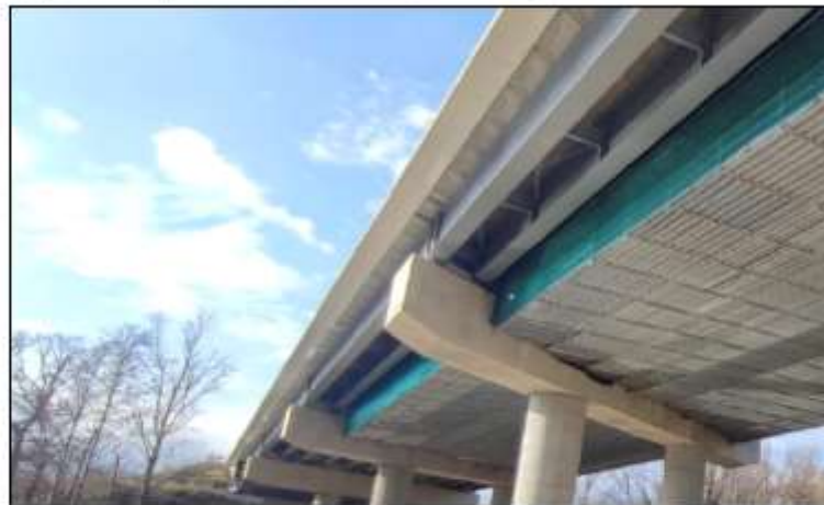
Figure 41 : Exemple de platelages confinés sous tablier d'ouvrage, vue extérieure (source : Arcadis)
