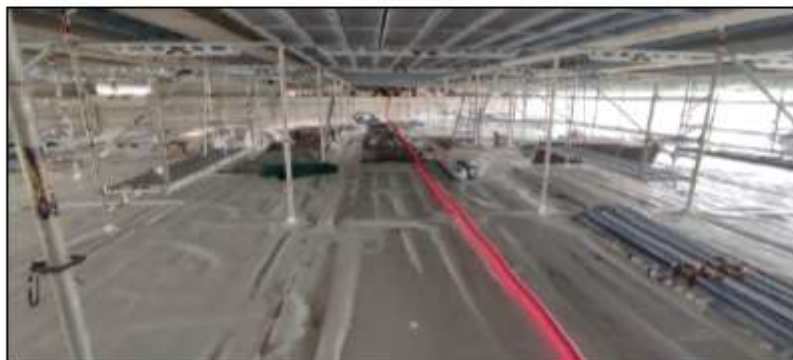
Figure 42 : Exemple de platelages confinés sous tablier, vue intérieure (source : Arcadis)
