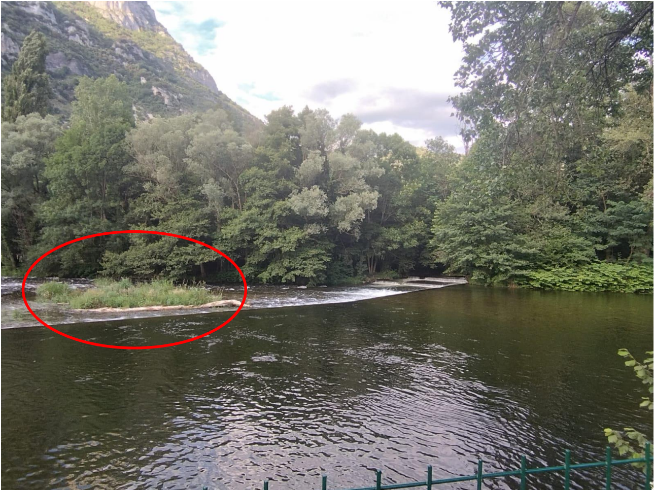
Figure 10: Atterrissement à traiter à l'aval du barrage
