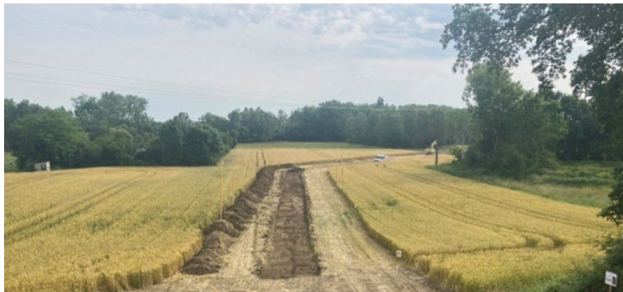
Figure 68 Vue d'un aménagement de piste pour la future pose de canalisation DN80
