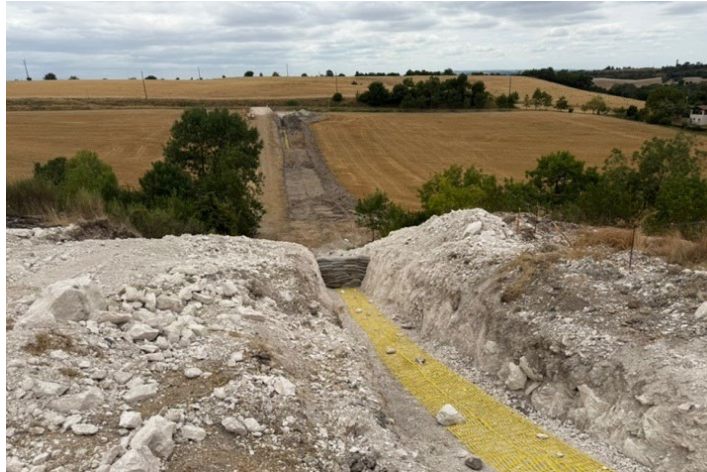
Figure 74 Fermeture progressive de la tranchée (et pose du grillage avertisseur)
