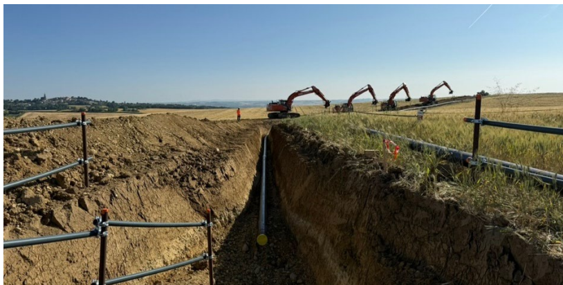
Figure 72 Ouverture de la tranchée à la pelle mécanique et pose de la canalisation en fond de fouille
