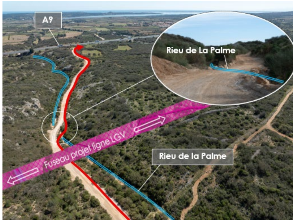
Figure 35 Cheminement par la voie d'accès de la carrière Combe Nègre (Source : ETC21 / Piece 3)
