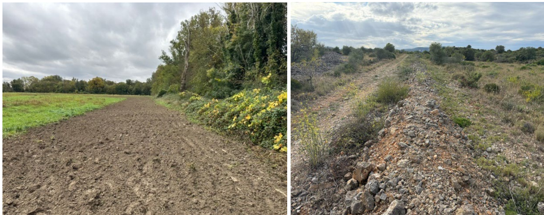
Figure 76 Remise en état en zone agricole (terrains meubles) et en zone de garrigue (terrains rocheux)
