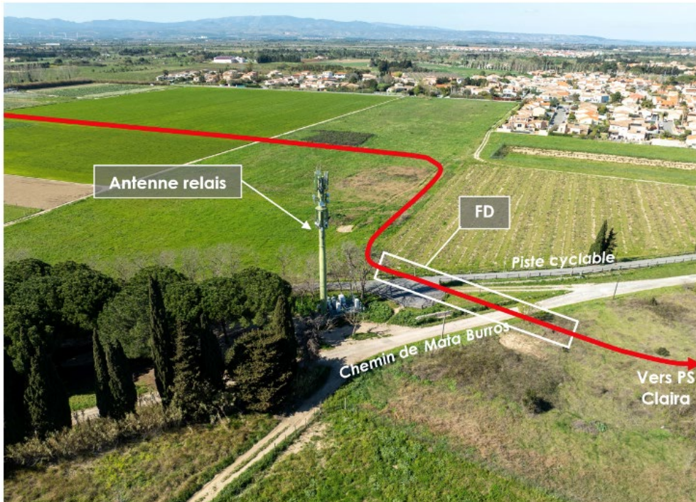
Figure 61 Traversée de la piste cyclable en forage droit (Source : ETC2I / Piece 3)
