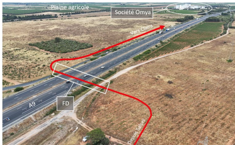
Figure 52 Traversée de l'autoroute A9 en FD
