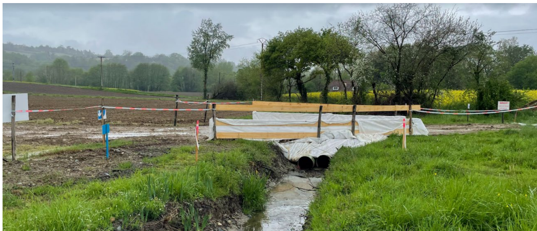
Figure 81 Gaines métalliques recouvertes d'un platelage en rondins de bois (photo : GRENA)
