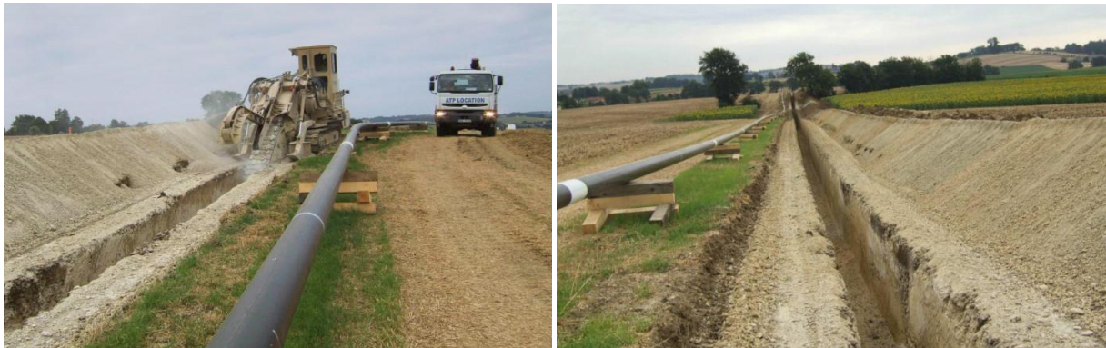
Figure 73 : Ouverture d'une tranchée réalisée à la trancheuse.
