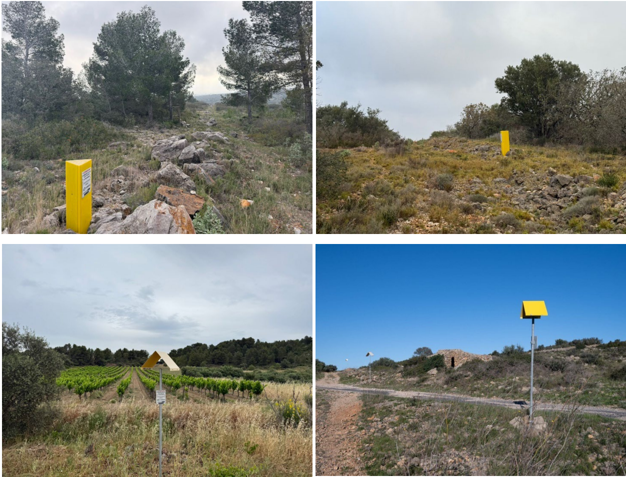
Figure 77 Bornes et balises indiquant la présence de la canalisation enterrée
