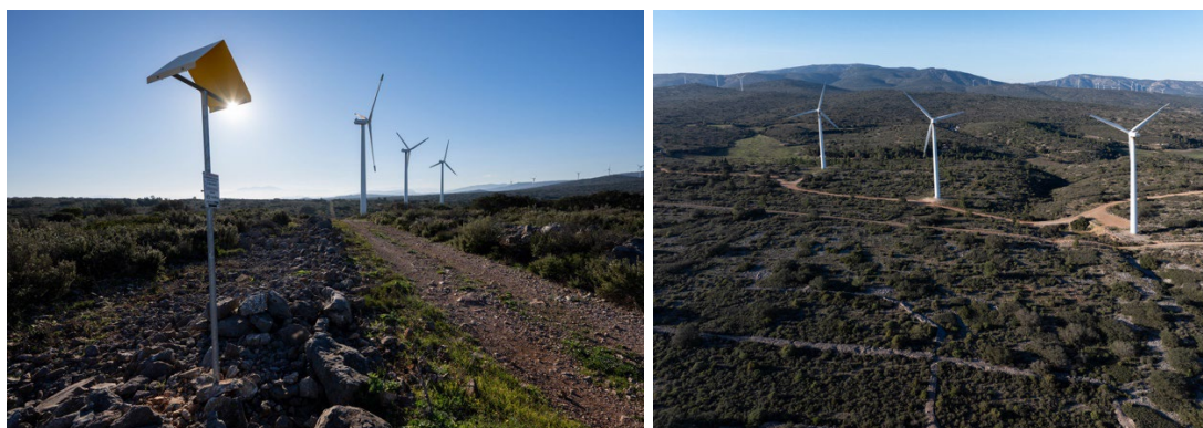
Parc éolien actuellement présent dans le massif des Corbières non loin de la canalisation existante
