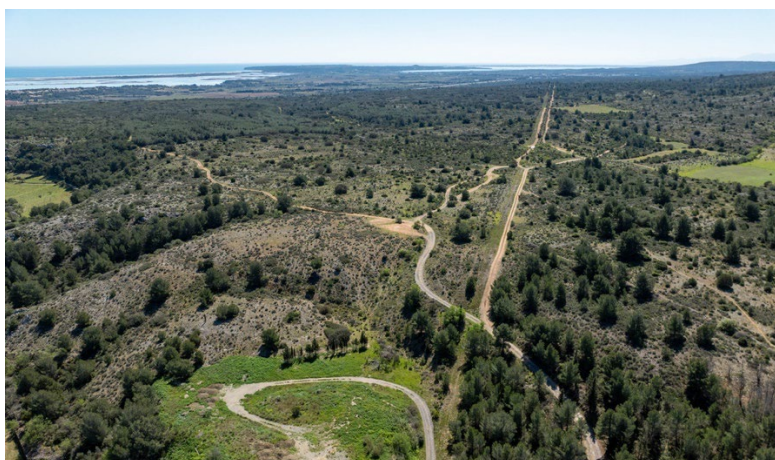
Tracé de la canalisation en parallèle du chemin DFCI traversant les Corbières
