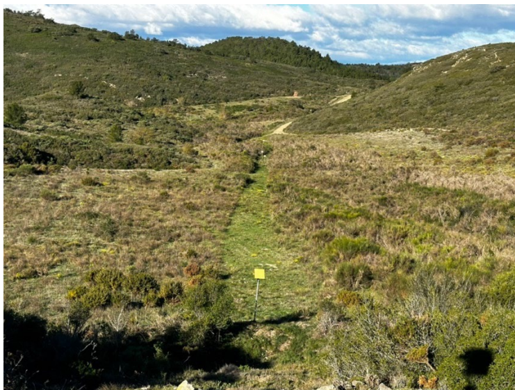
Vue d'un tronçon de la canalisation existante en milieu naturel à Narbonne.
