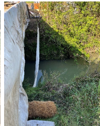
Bac de rétention à gauche / barrage absorbant prêt à être déployé, à droite
