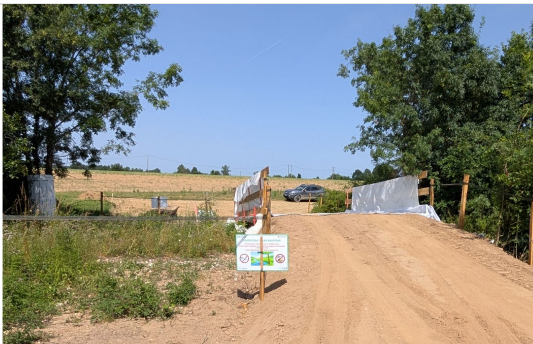
Exemple : balisage, préservation de la zone tampon et protection physique des arbres à protéger aux abords de cours d'eau
