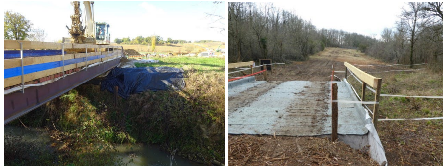
Exemple de franchissements par pont (photo GRENA Consultant)
