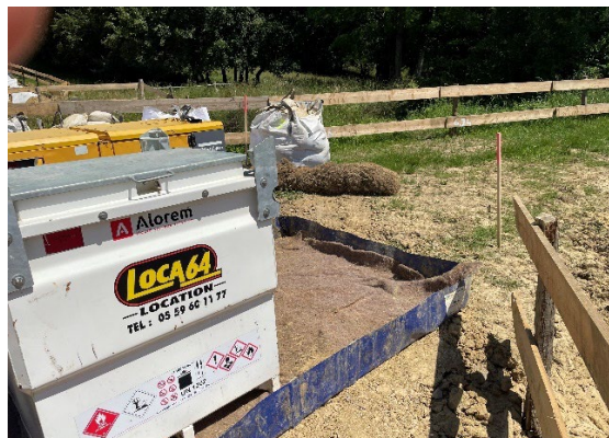
Bac de rétention à gauche / barrage absorbant prêt à être déployé, à droite
