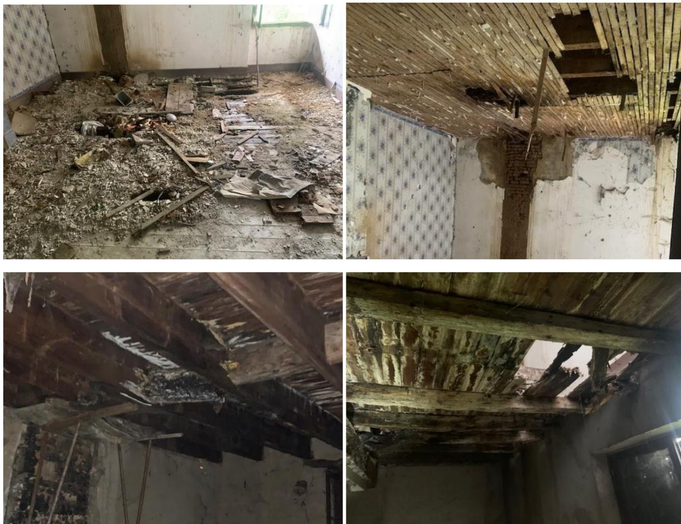
Figure 6 : Etat de dégradation au sein des bâtiments (photographies prises par Armand Miatto, groupe SPJM/PRISM)
